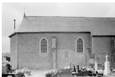
Façade nord (chœur). Phot. Jean-Michel Périn IVR31_19806203584X
