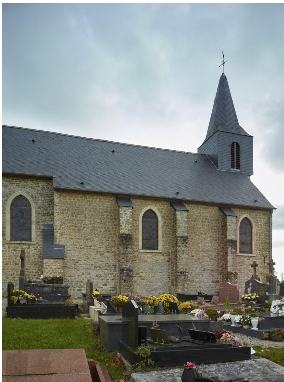
Vue de l'élévation nord.
