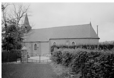
Façade sud. Phot. Jean-Michel Périn IVR31_19806203642X
