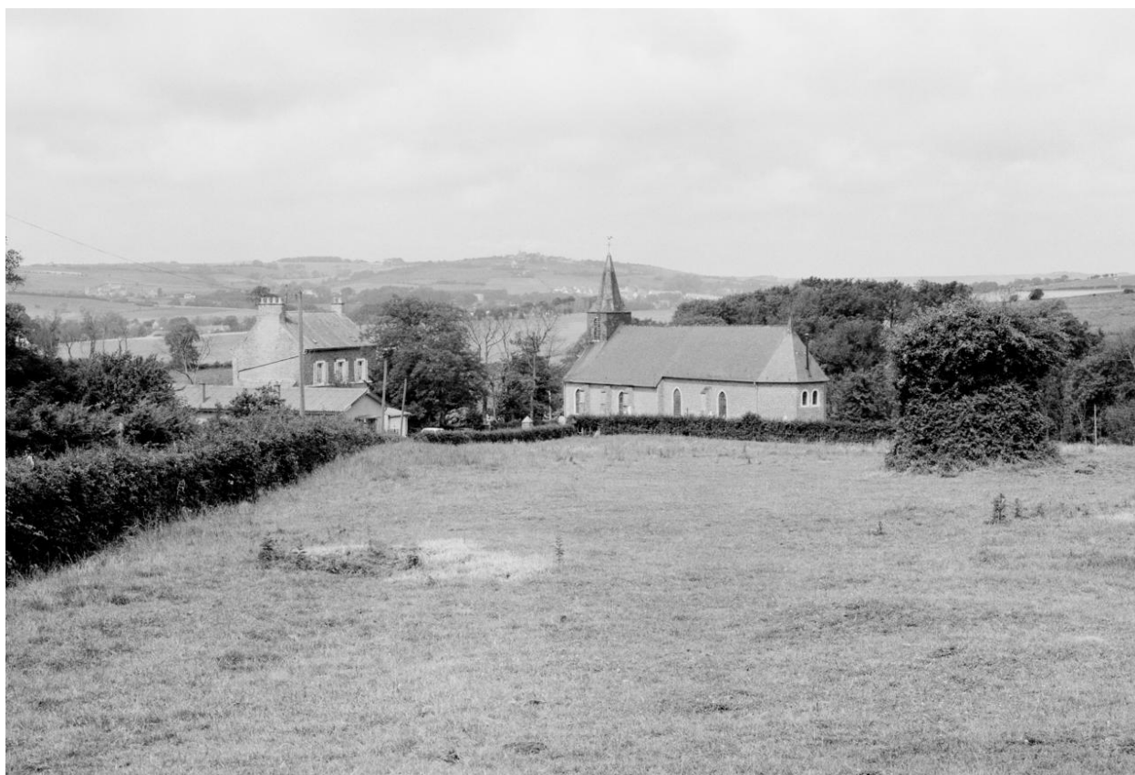
Vue générale de l'église dans son environnement.
