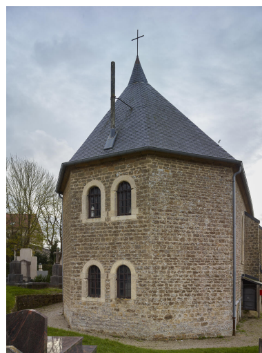
Vue du chevet. Phot. Pierre Thibaut IVR32_20236200989NUCA
