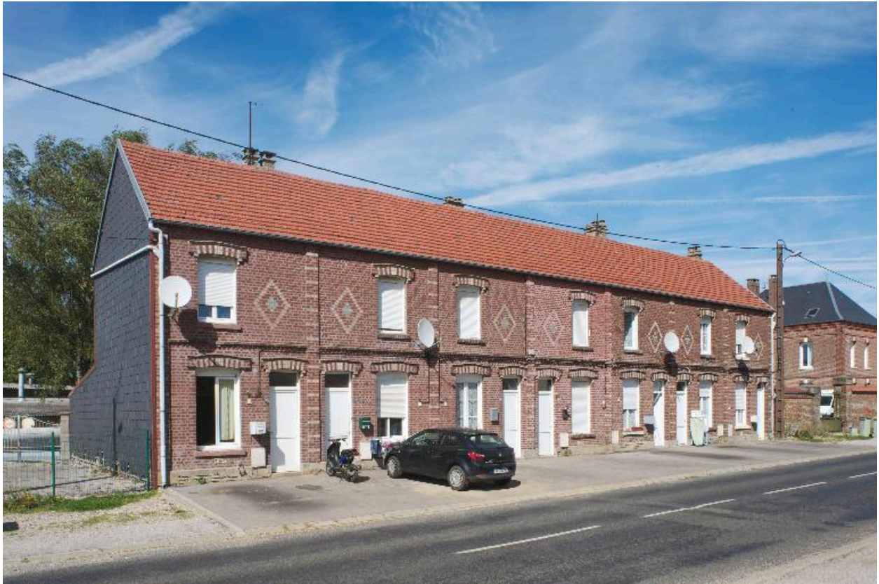
Vue générale depuis la rue du Chevalier-de-la-Barre
