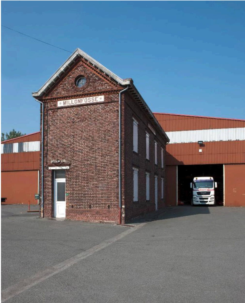
Vue de trois quarts, l'élévation postérieure.
