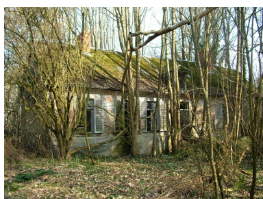
Ancien presbytère. Phot. Frédéric Fournis IVR22_20118001071NUCA
