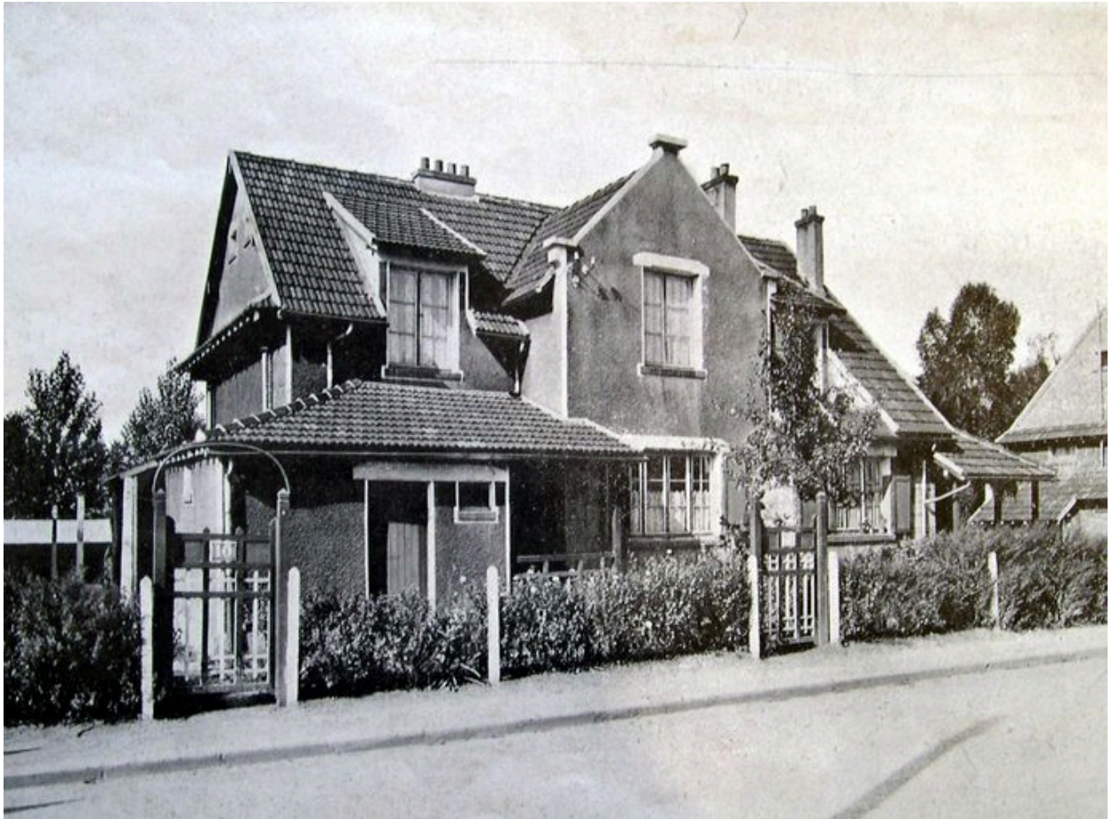
La cité jardin du Château Tourtier (pl. 15) La construction Moderne, n° 4, 24 octobre 1926 (allée des Rosiers)
