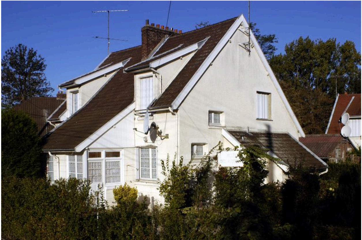
Maison à deux unités d'habitation (2 logements de 4 pièces), 8 et 10 allée des Aubépines. Vue prise en 2004 avant restauration.
