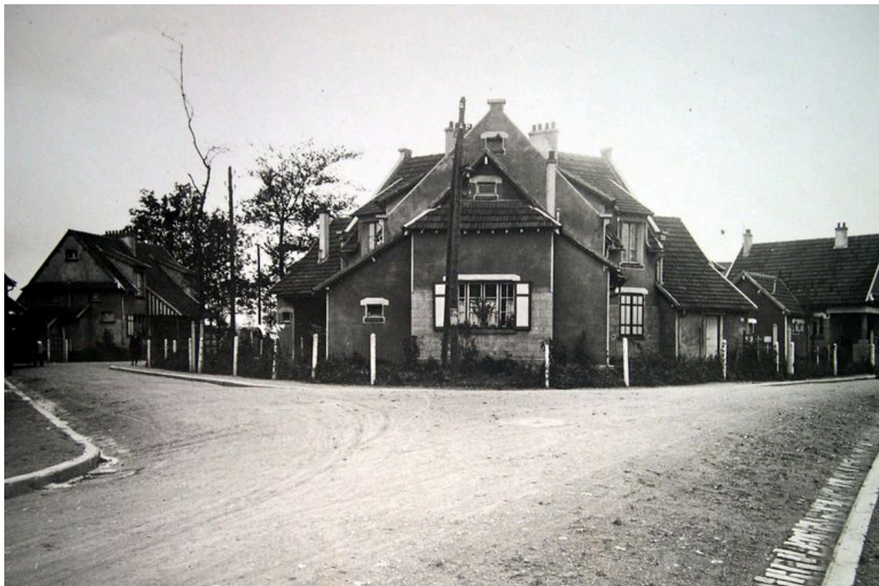
Longueau. Petite cité (au centre la maison du 1 allée des Rosiers), photographie, vers 1924 (AN/CAMT ; 202 AQ 1189)
