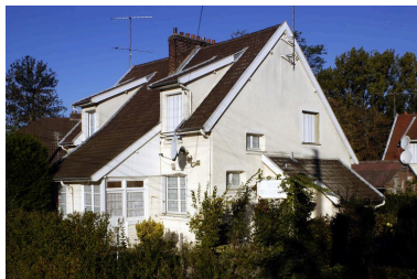
Maison à deux unités d'habitation (2 logements de 4 pièces), 8 et 10 allée des Aubépines. Vue prise en 2004 avant restauration. Phot. Thierry Lefébure IVR22_20048000371NUCA
