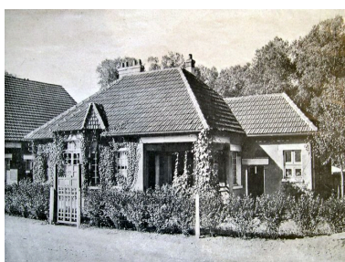
La cité jardin du Château Tourtier (pl. 16) La construction Moderne, n° 4, 24 octobre 1926 (15 rue des Acacias) Phot. Isabelle Barbedor IVR22_20048010762NUCA
