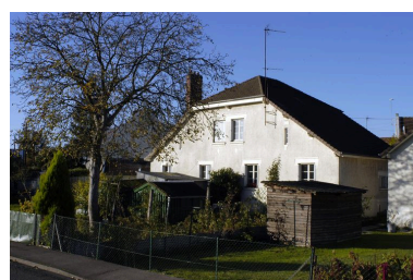
Maisons, allée des Tilleuls, vue des façades arrières. Vue prise en 2004 avant restauration. Phot. Thierry Lefebure IVR22_20048000372NUCA
