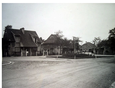
Longueau. Petite cité (place et allée des Aubépines), photographie, vers 1924 (AN/CAMT ; 202 AQ 1189) Phot. Centre des Archives du Monde du Travail IVR22_20048010748NUCA
