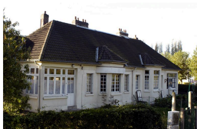
Maison à deux unités d'habitation (modèle A), 17 allée des Acacias et 16 allée des Jardiniers. Vue prise en 2004 avant restauration. Phot. Thierry Lefébure IVR22_20048000366NUCA
