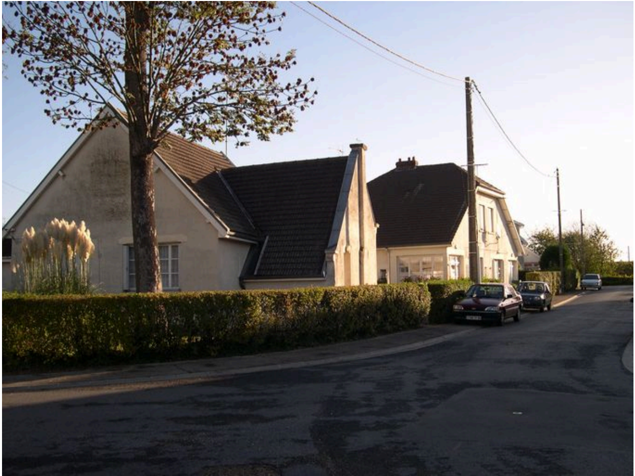
L'allée des Aubépines, vue prise en 2004 depuis la rue des Acacias avant restauration.
