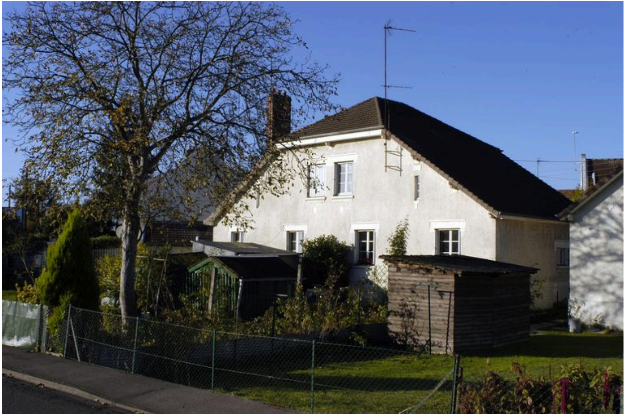
Maisons, allée des Tilleuls, vue des façades arrières. Vue prise en 2004 avant restauration.
