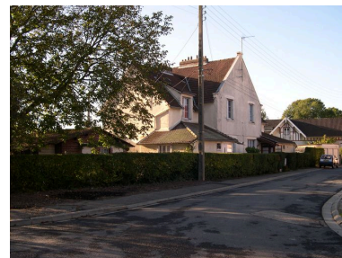
Maison à quatre unités d'habitation (4 logements de 4 pièces), 8 à 14 allée des Tilleuls. Vue prise en 2004 avant restauration. Phot. Isabelle Barbedor IVR22_20048010452NUCA
