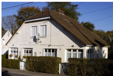
Maison, allée des Jardiniers. Vue prise en 2004 avant restauration. Phot. Thierry Lefébure IVR22_20048000370NUCA
