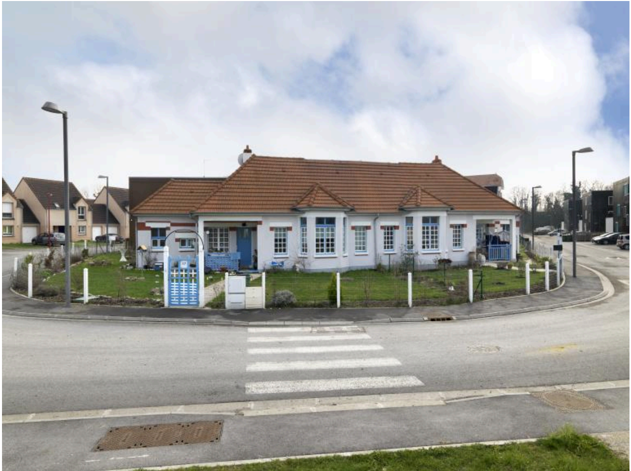
Maison à deux unités d'habitation (modèle A), 17 allée des Acacias et 16 allée des Jardiniers.
