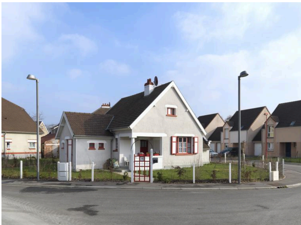
Maison, 1 allée des Rosiers.
