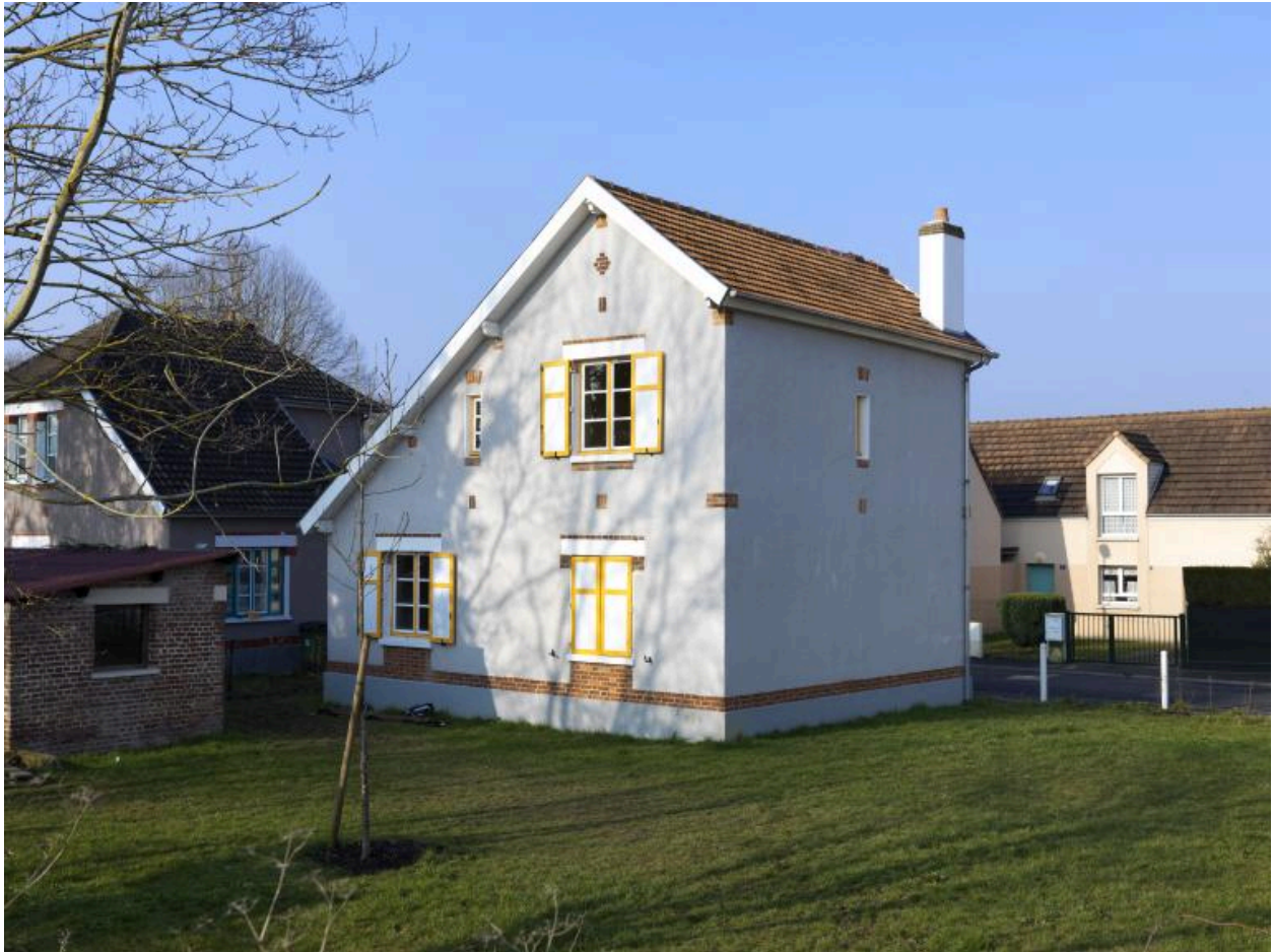
Maison. Rue des Tilleuls.
