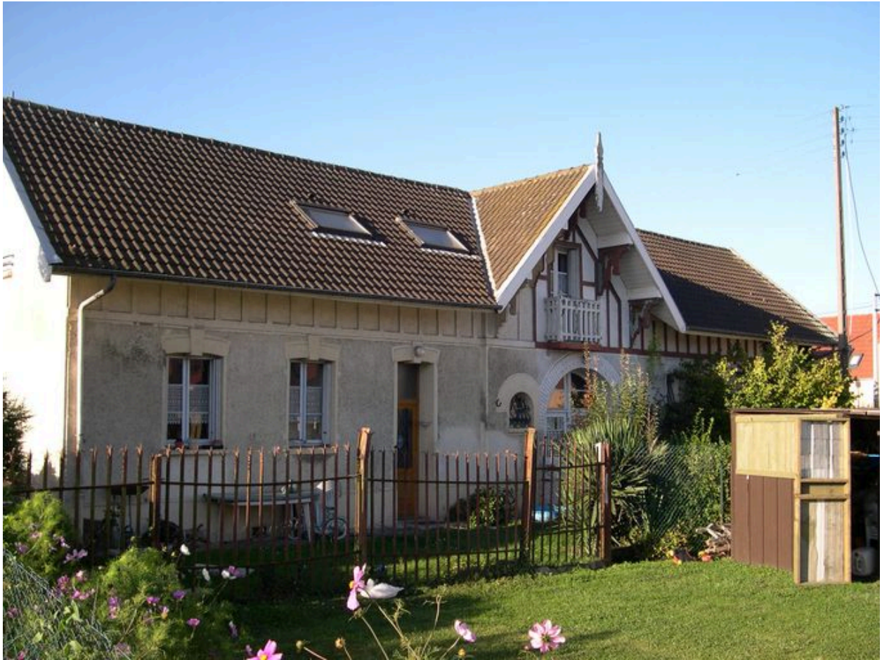
Ancienne dépendance du château (?), rue des Tilleuls. Vue prise en 2004 avant restauration.
