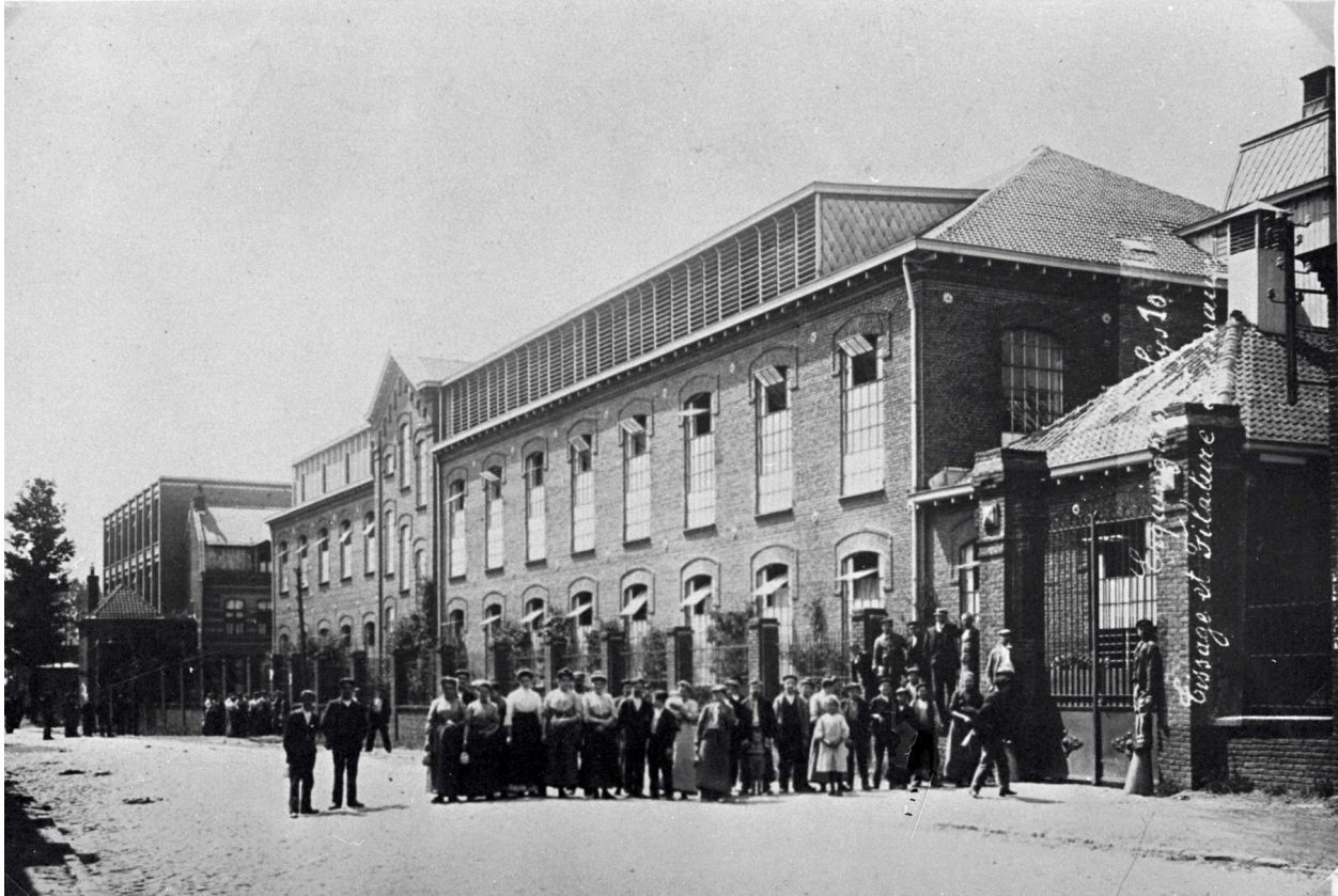
Tissage et filature Frémeaux (sic). Élévation antérieure. Photographie, photographe inconnu, [avant 1914] (AC Bois-Grenier).
