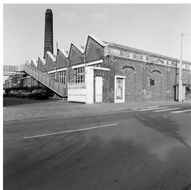
Atelier de fabrication. Élévation sur cour depuis la rue. Phot. Olivier Marlard IVR31_19905901058X
