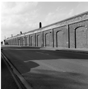
Atelier de fabrication. Élévation sur rue. Phot. Olivier Marlard IVR31_19905901059X
