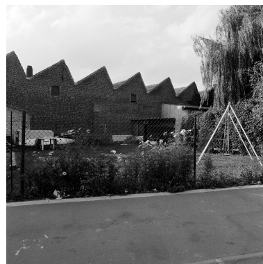
Atelier de fabrication. Élévation sur jardin. Phot. Olivier Marlard IVR31_19905901060X
