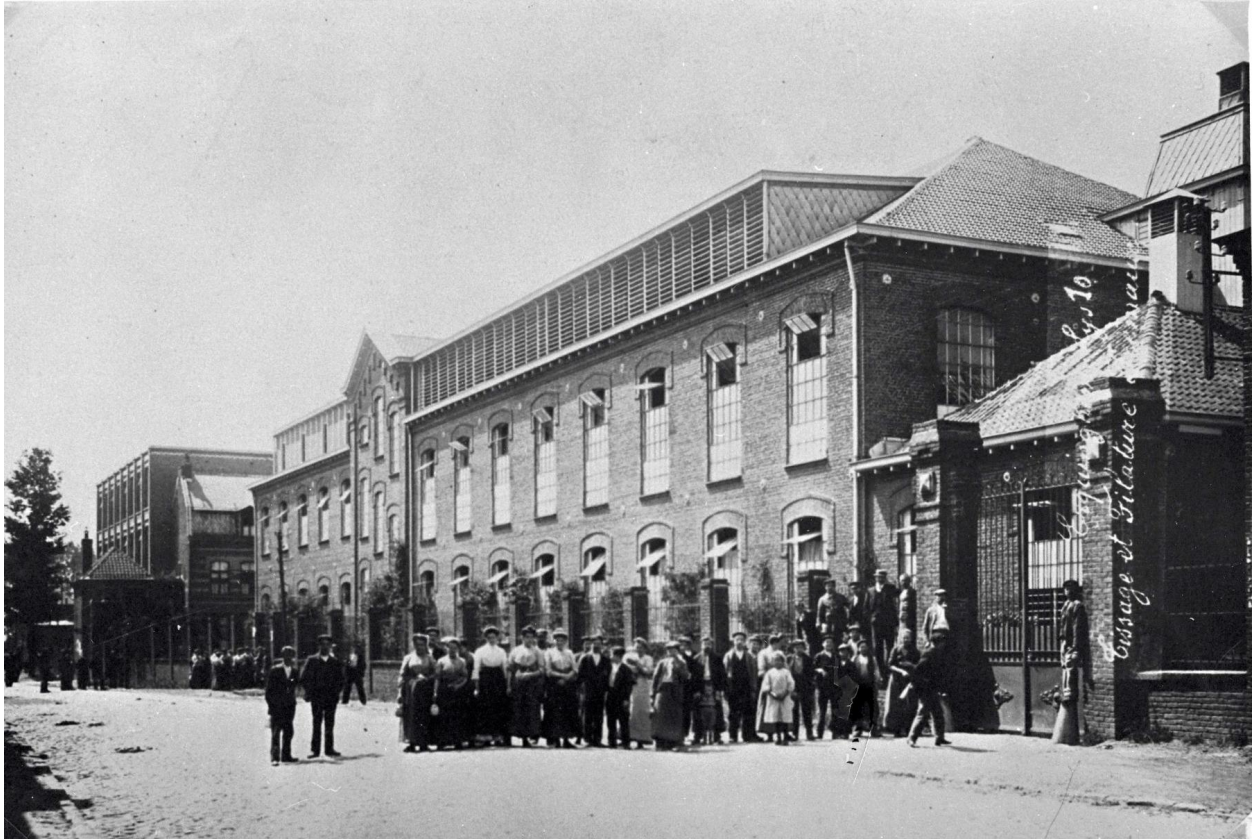
Tissage et filature Frémaux (sic). Élévation antérieure. Photographie, photographe inconnu, [avant 1914] (AC Bois-Grenier).
