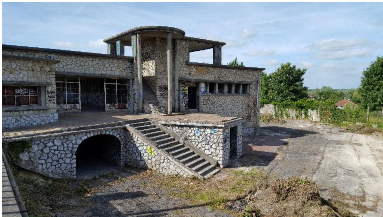
Amiens (Somme). Les anciens vestiaires de la piscine de la Compagnie des Chemins de fer du Nord, dite La Cheminote, reconstruits en 1947, sur les plans de Pierre et André Dufau.
