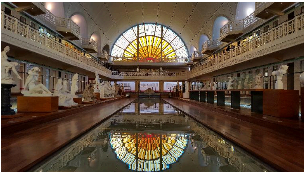
Roubaix (Nord). La piscine municipale construite sur les plans de l'architecte Albert Baert et inaugurée en 1932. La reconversion du site (aujourd'hui musée d'art et d'industrie) est réalisée sur les plans de l'architecte Jean-Paul Philippon.
