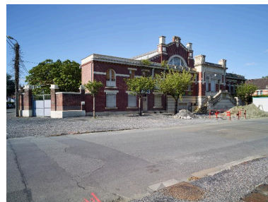
Saint-Amand-les-Eaux (Nord). La piscine municipale construite en 1925, sur les plans de l'architecte Léon Raux. Phot. Pierre Thibaut IVR31_20155901410NUCA
