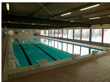
Doullens (Somme). La piscine Plein Soleil, modèle de Marc Revaux, ouverte en 1976. Phot. Marie-Laure Monnehay-Vulliet
