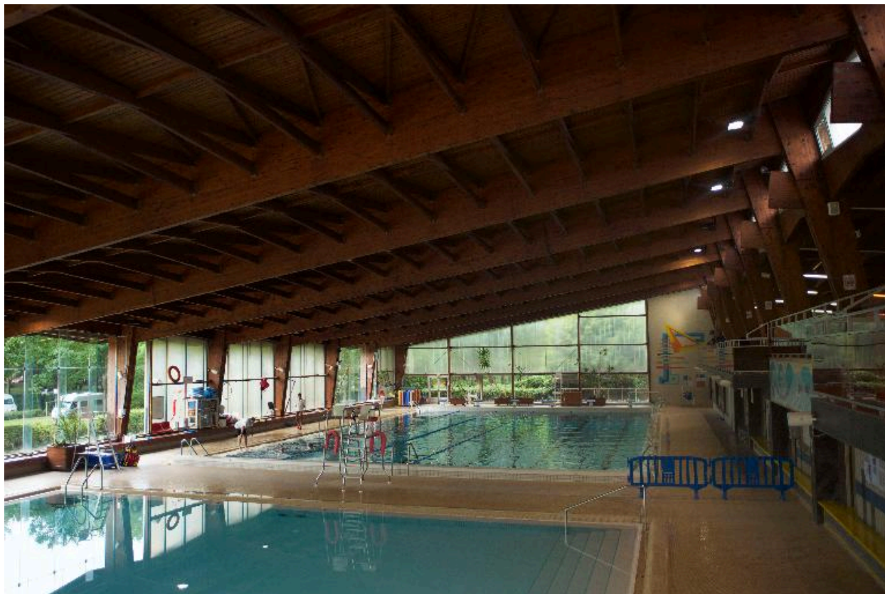
Soissons (Aisne). La piscine couverte (modèle type agréé en 1970) construite sur les plans de l'architecte Doldourian et inaugurée en 1976.
