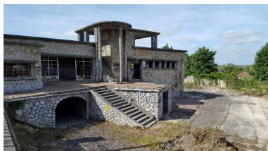
Amiens (Somme). Les anciens vestiaires de la piscine de la Compagnie des Chemins de fer du Nord, dite La Cheminote, reconstruits en 1947, sur les plans de Pierre et André Dufau. Phot. Laurence Schlosser IVR32_20178005073NUCA
