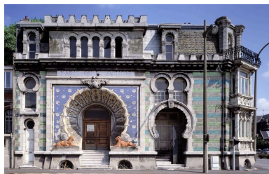
Dunkerque (Nord). Les anciens Bains Dunkerquois, 1896. Phot. Jean-Michel Périn IVR31_19865902296XA
