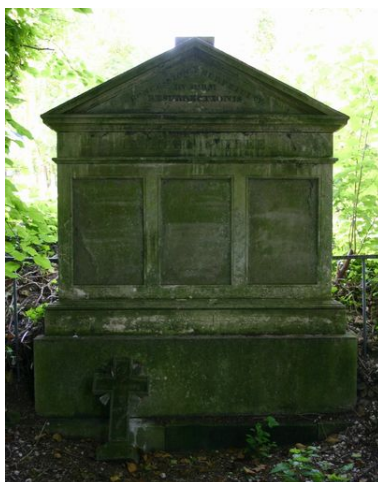
Stèle à entablement et fronton. Phot. Caroline Vincent IVR22_20088000473NUCA
