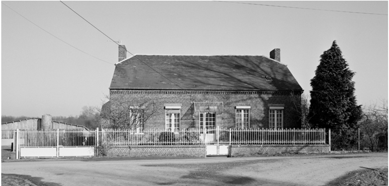
Façade du logis.
