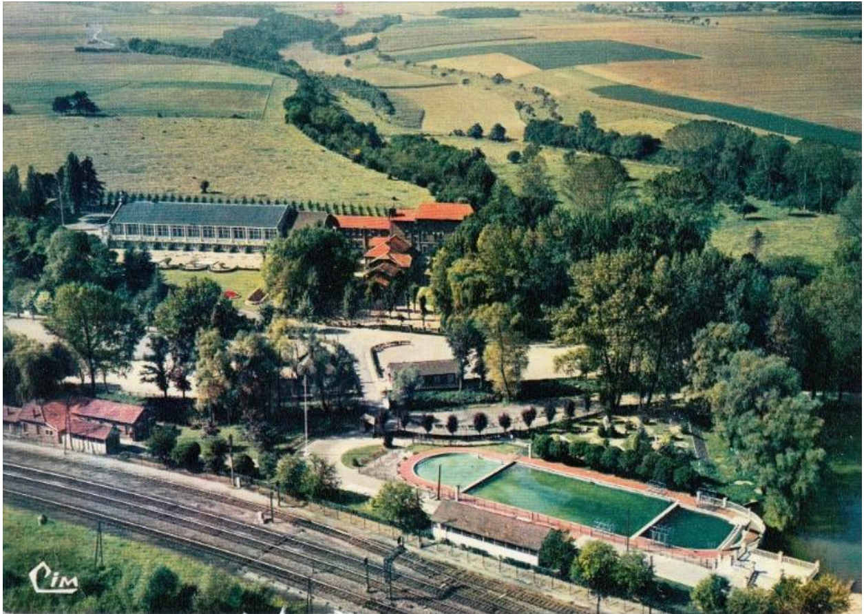
Vue aérienne du centre de vacances de la S.N.C.F. à Montdidier, à proximité de la voie de chemin de fer : auberges de jeunesse, installations de loisir et sportives (piscine, etc.), carte postale, [vers 1970] (coll. part.).
