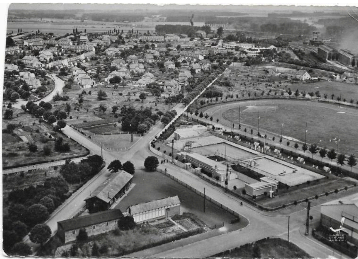
Vue aérienne de la cité des cheminots de Tergnier, du stade et de la piscine, reconstruite après-guerre, carte postale, vers 1960 (coll. part.).
