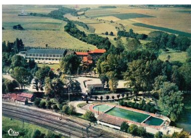
Vue aérienne du centre de vacances de la S.N.C.F. à Montdidier, à proximité de la voie de chemin de fer : auberges de
