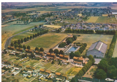
Vue aérienne de la piscine de l'usine Béghin à Thumeries, carte postale, vers 1960 (coll. part.). Phot. Laurence Schlosser (reproduction) IVR32_20175905004NUCA
