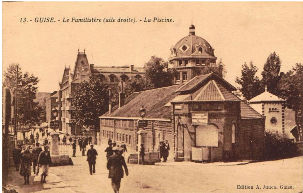
Vue du bâtiment du lavoir-buanderie-piscine du Familistère de Guise, carte postale, vers 1900 (coll. part.).
