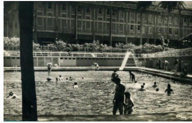
Baignade à la piscine de la centrale thermique de Vendin-le-Vieil, carte postale, vers 1950 (coll. part.). Phot. Laurence Schlosser (reproduction) IVR32_20176205048NUCA
