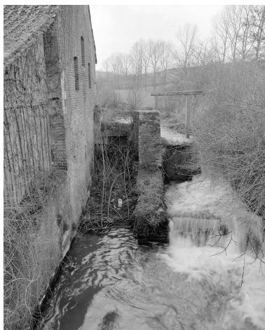
Vue depuis l'est, emplacement de la roue hydraulique et ancien vannage en 1993. Phot. Olivier Marlard IVR31_19936200469X
