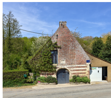
Vue de l'élévation sud en 2023. Phot. Thierry Lefébure IVR32_20236200428NUCA
