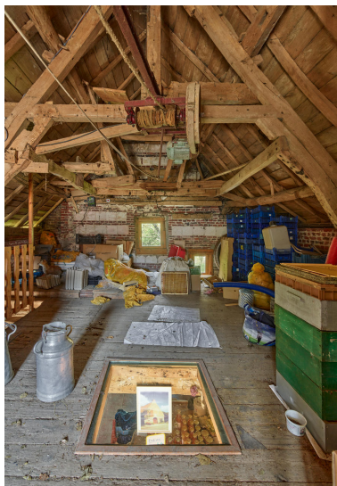
Vue intérieure de l'étage sous comble. Phot. Thierry Lefébure IVR32_20236200436NUCA
