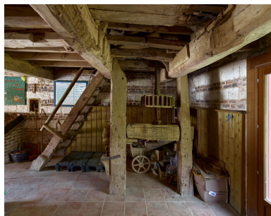
Vue du beffroi et de la lanterne, vestiges des mécanismes de transmission du moulin. Phot. Thierry Lefébure IVR32_20236200435NUCA
