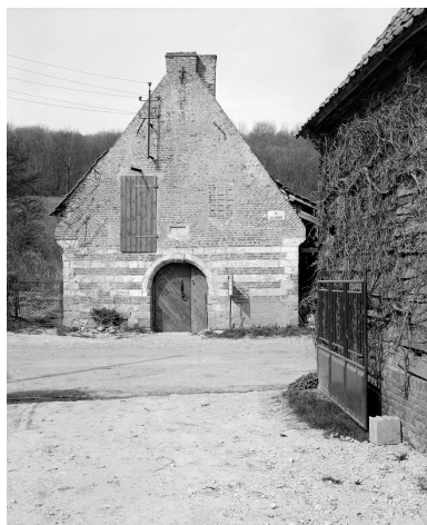
Vue de l'élévation sud en 1993. Phot. Olivier Marlard IVR31_19936200466X
