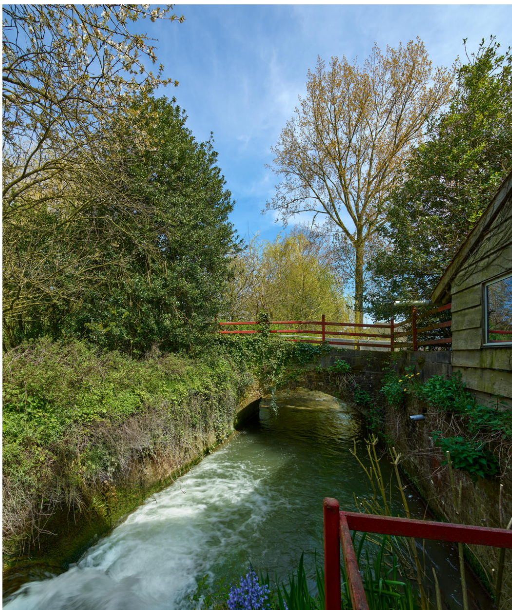
Vue depuis l'élévation nord du moulin vers le pont.
