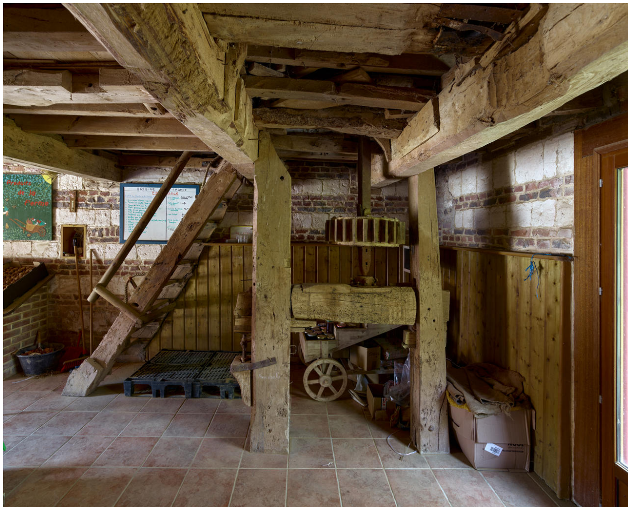
Vue du beffroi et de la lanterne, vestiges des mécanismes de transmission du moulin.
