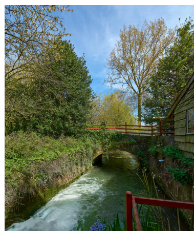
Vue depuis l'élévation nord du moulin vers le pont. Phot. Thierry Lefébure IVR32_20236200434NUCA
