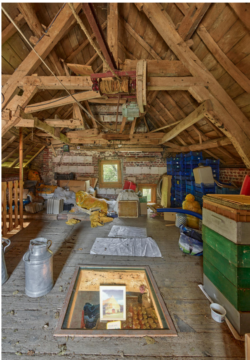
Vue intérieure de l'étage sous comble.
