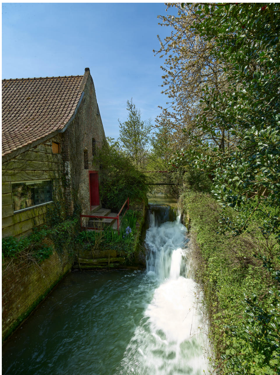
Vue du vannage et de l'emplacement de la roue disparue.
