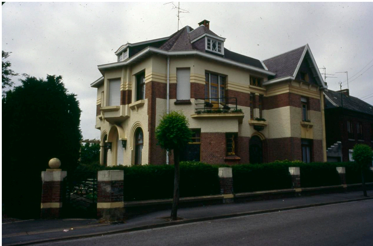
Élévation de trois-quarts depuis la rue.
