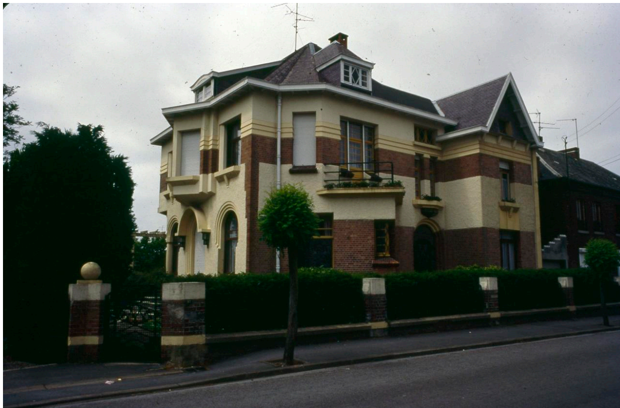
Élévation de trois-quarts depuis la rue.
