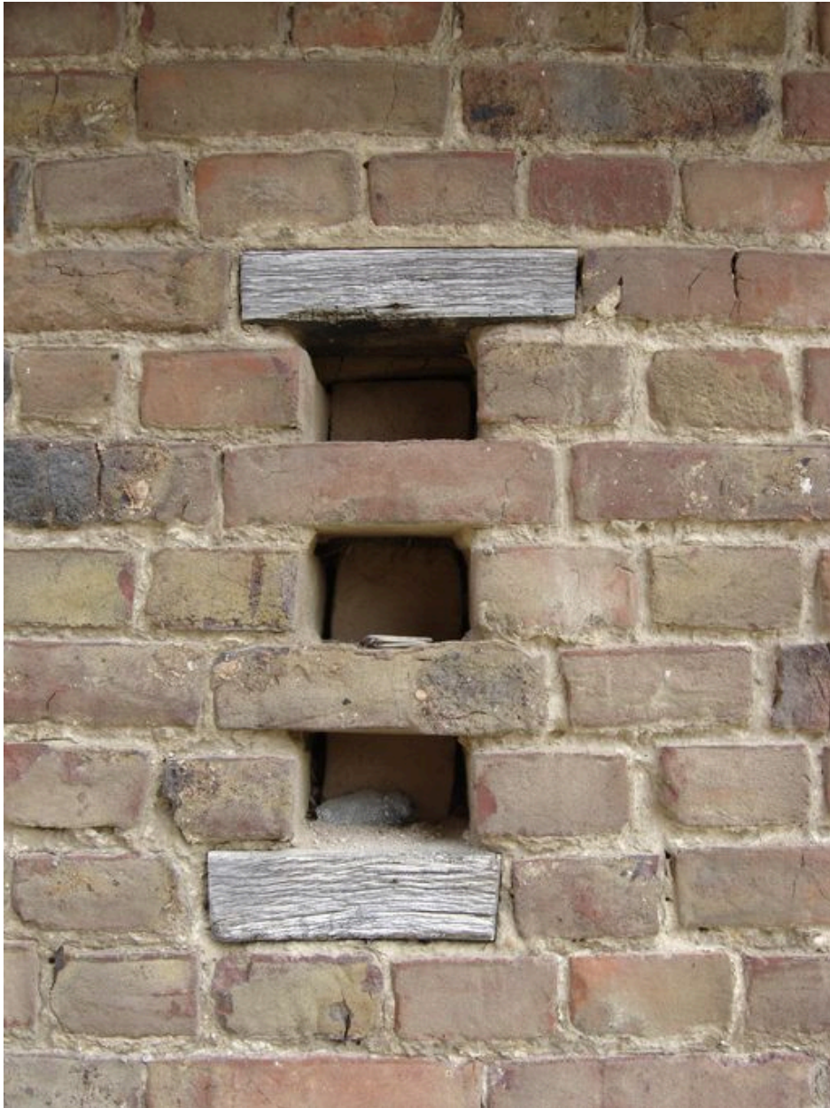
Vue des aérations sur rue.
