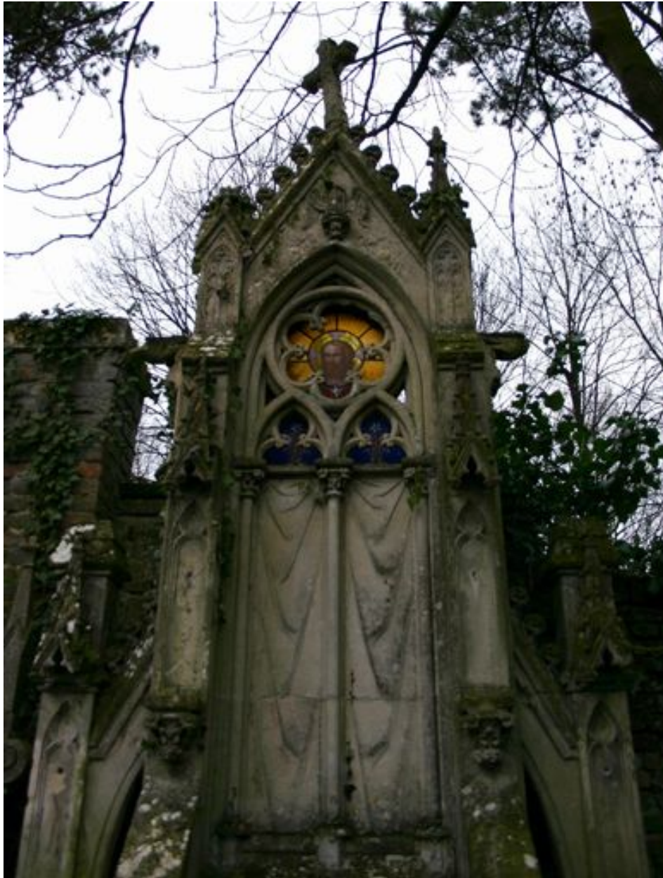
Détail de la partie supérieure de la stèle architecturée.
