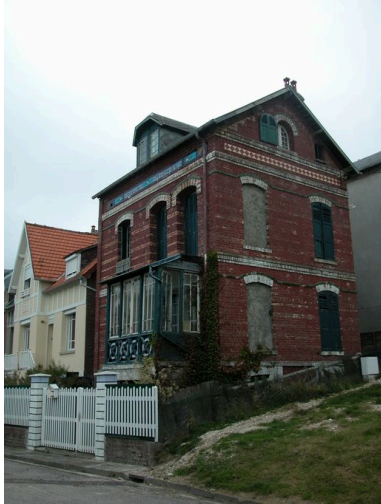
Vue d'ensemble et de trois-quarts. Phot. Elisabeth Justome IVR22_20048001569NUCA
