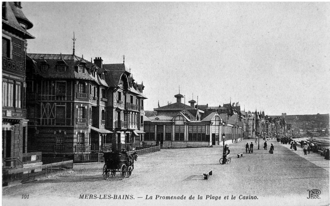
L'esplanade près du casino, au premier plan, l'îlot 15 aujourd'hui totalement détruit, carte postale, 1er quart 20e siècle (coll. part.).
