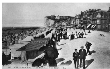
L'esplanade et les cabines de l'établissement de bains froids, carte postale, 1er quart 20e siècle (coll. part.). Phot. Monnehay-Vulliet Marie-Laure IVR22_20048000516XB
