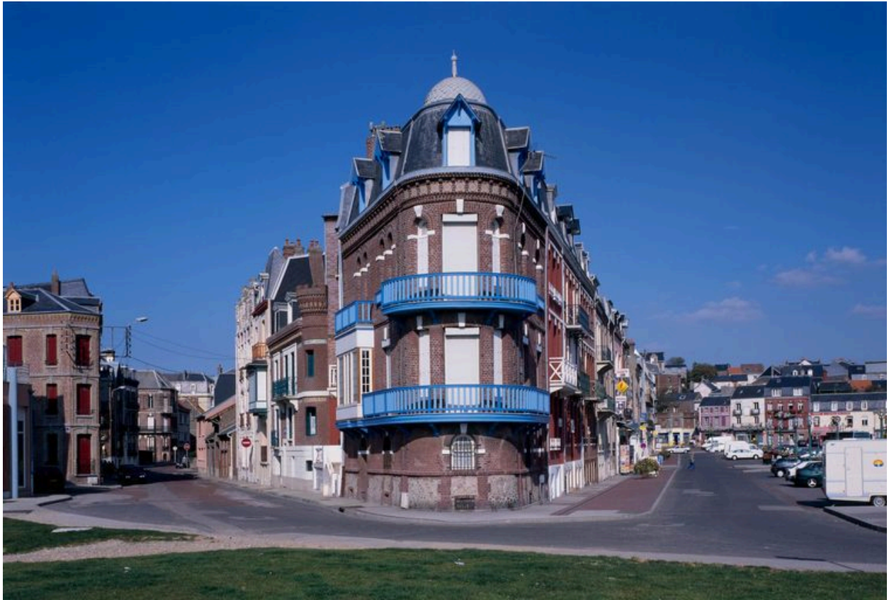
Traitement d'angle du lotissement balnéaire (îlot 16), avec la Prairie à droite.
