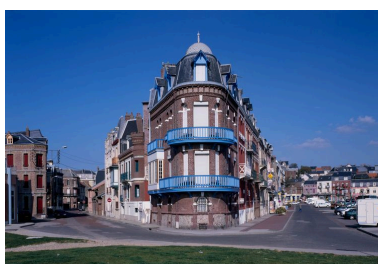
Traitement d'angle du lotissement balnéaire (îlot 16), avec la Prairie à droite.
