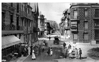
L'avenue de la gare, actuelle avenue du Maréchal-Foch, carte postale, 1er quart 20e siècle (coll. part.). Phot. Monnehay-Vulliet Marie-Laure IVR22_20048000507XB
