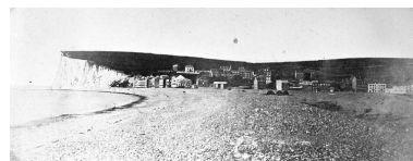
La station et ses premières villas, photographie, 4e quart 19e siècle (coll. part.). Phot. Monnehay-Vulliet Marie-Laure IVR22_20048000539XB
