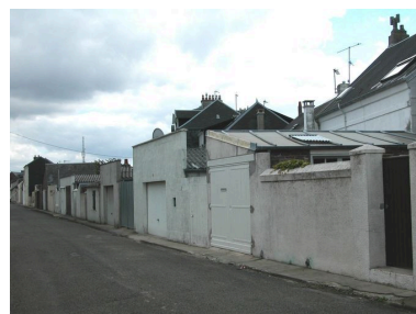
La rue du Mont-Rôti, vue sur les annexes et garages des maisons implantées le long de l'avenue Carnot. Phot. Elisabeth Justome IVR22_20058003134NUCA
