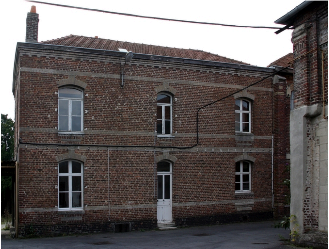
Façade antérieure du logement de contremaître.
