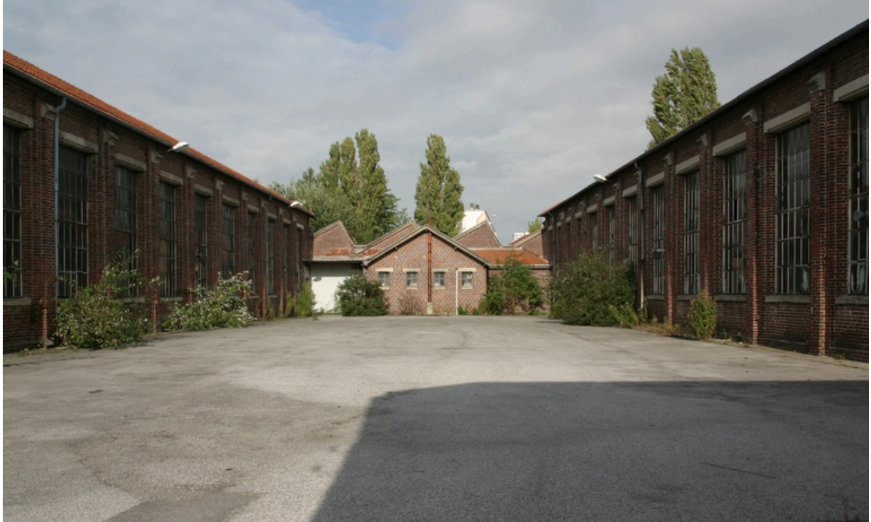
Les deux grands ateliers de guipure reconstruits à partir de 1919. Au fond, l'atelier de préparation.
