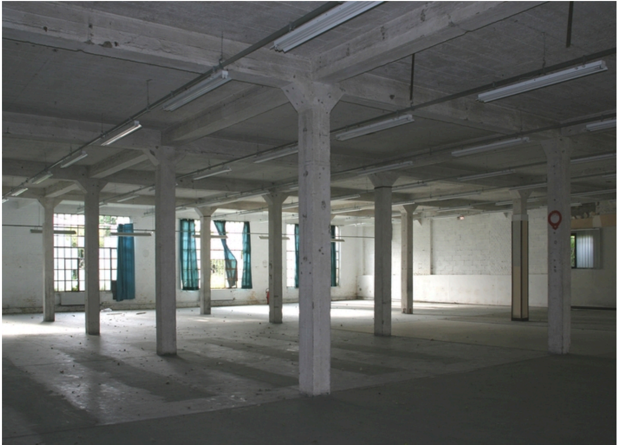
Ateliers à deux niveaux datant de la reconstruction : vue du rez-de-chaussée et de la structure poteau-poutre en béton armé.
