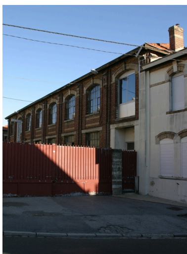
Entrée de l'usine : conciergerie et bureaux. Phot. Frédéric Pillet IVR22_20040201026NUCA
