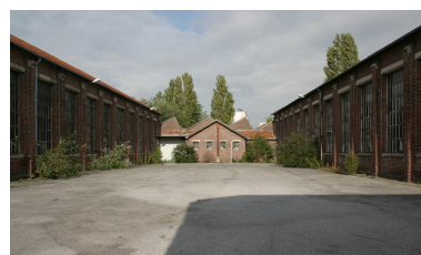
Les deux grands ateliers de guipure reconstruits à partir de 1919. Au fond, l'atelier de préparation. Phot. Frédéric Pillet IVR22_20040201045NUCA
