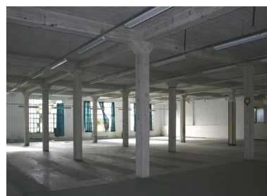
Ateliers à deux niveaux datant de la reconstruction : vue du rez-de-chaussée et de la structure poteau-poutre en béton armé. Phot. Frédéric Pillet IVR22_20040201039NUCA
