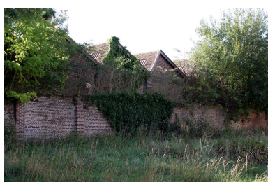
Pignons et sheds de l'atelier de préparation reconstruit après 1918. Phot. Frédéric Pillet IVR22_20040201046NUCA
