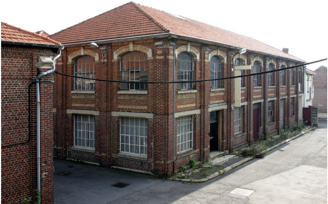
Les bureaux reconstruits après la Première Guerre mondiale.
