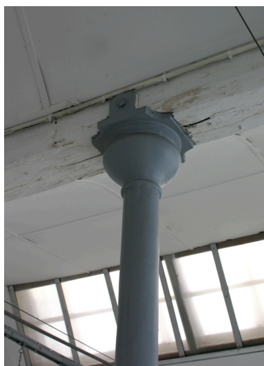
Ateliers antérieurs à 1900 (ensemble ouest) : chapiteau d'une colonne en fonte de l'étage. Phot. Frédéric Pillet IVR22_20040201037NUCA
