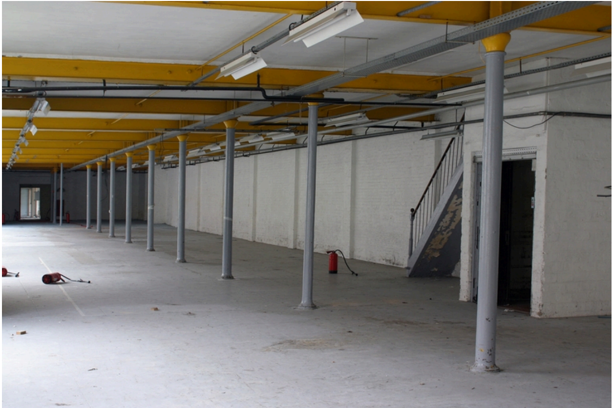
Ateliers antérieurs à 1900 (ensemble ouest) : vue du rez-de-chaussée.
