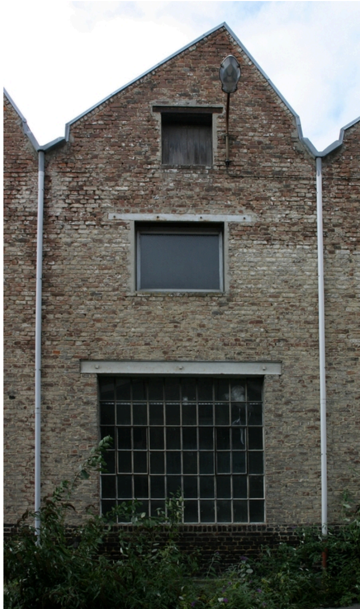
Ateliers antérieurs à 1900 (ensemble ouest) : une travée de la façade orientale.
