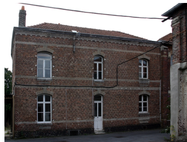
Façade antérieure du logement de contremaître.
