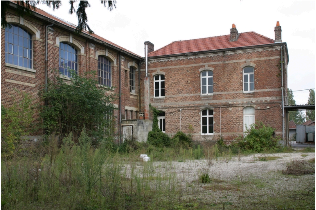
Façade postérieure du logement de contremaître et façade orientale des bureaux.
