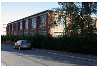
Ateliers à deux niveaux datant de la reconstruction : vue depuis la rue Jacky-Tabar. Phot. Frédéric Pillet IVR22_20040201038NUCA
