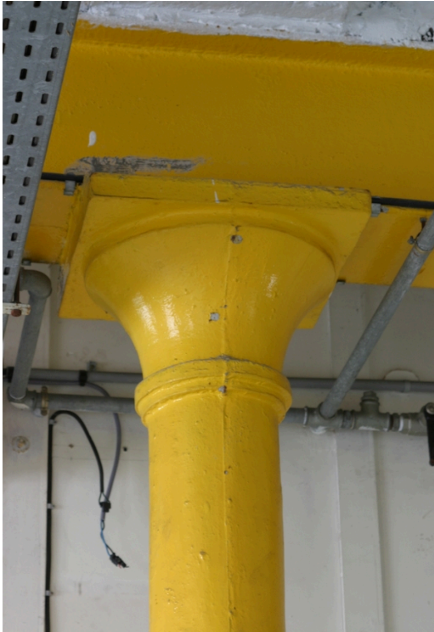
Ateliers antérieurs à 1900 (ensemble ouest) : chapiteau d'une colonne en fonte du rez-de-chaussée.
