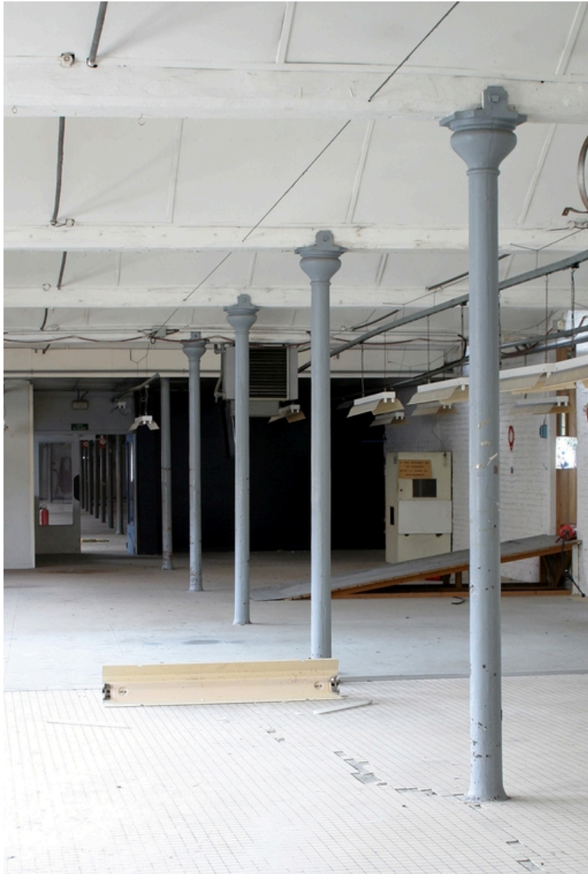
Ateliers antérieurs à 1900 (ensemble ouest) : vue de l'étage.
