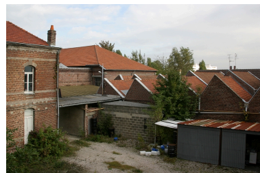
De gauche à droite : logement de contremaître, ancienne salle des machines (toit-terrace), l'un des deux grands ateliers de guipure, et ateliers d'ourdissage, de piquage des cartons, etc. (couverts de sheds).
