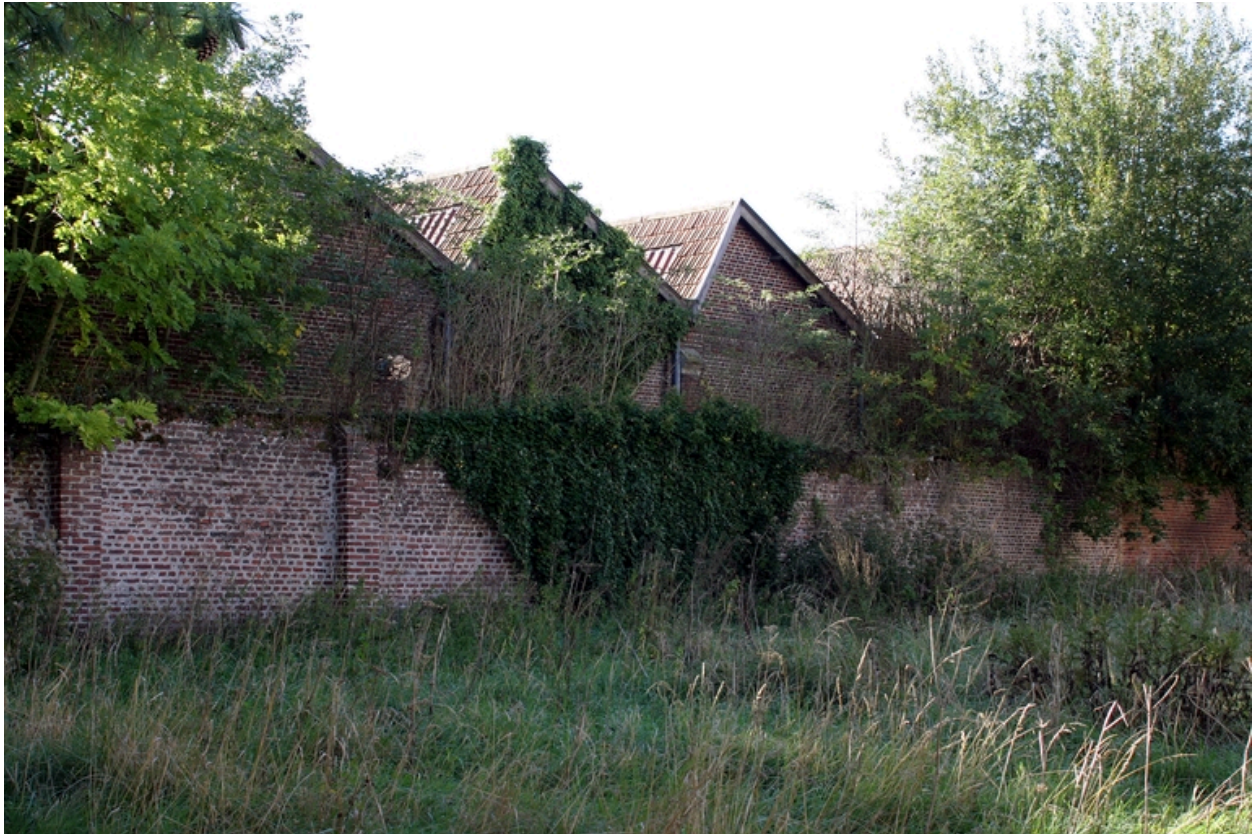
Pignons et sheds de l'atelier de préparation reconstruit après 1918.
