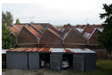
Vue des sheds couvrant les anciens ateliers d'ourdissage, de piquage des cartons, etc, construits avant 1900 et restaurés en 1919.
