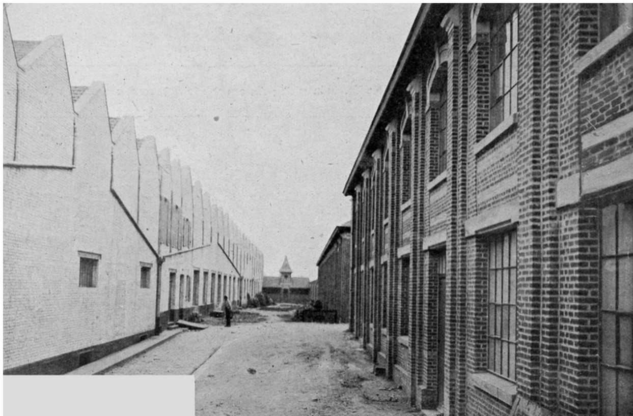
Des ateliers restaurés (à gauche) et reconstruits (à droite) en 1921 : aspect de la cour de la nouvelle usine vue de l'entrée (Le Monde Illustré).
