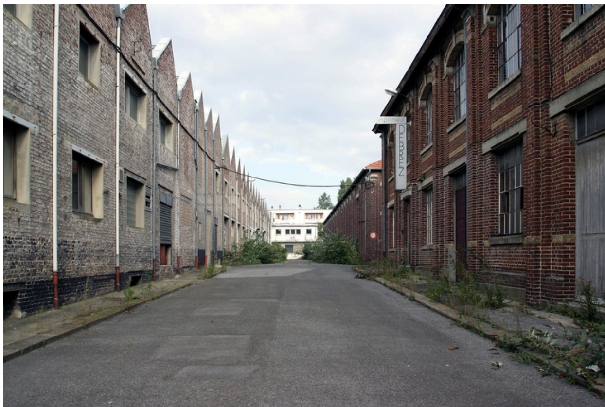
L'une des deux cours de l'usine : à gauche des ateliers du 19e siècle, à droite les bureaux et des ateliers reconstruits à partir de 1919.
