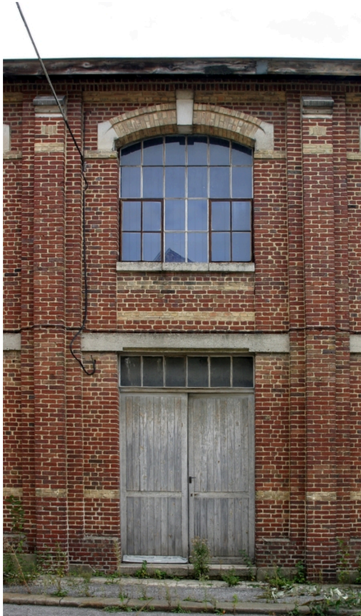
Une travée de la façade antérieure des bureaux.
