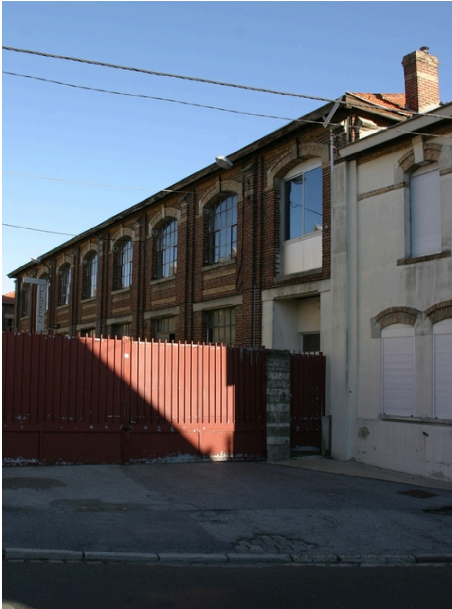
Entrée de l'usine : conciergerie et bureaux.
