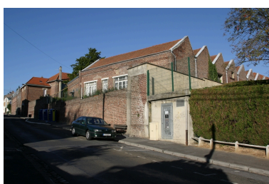
Vue depuis la rue Henri-Dunant des anciens ateliers d'ourdissage, de piquage des cartons, etc, restaurés en 1919. Au fond, à gauche, l'entrée de l'usine.
