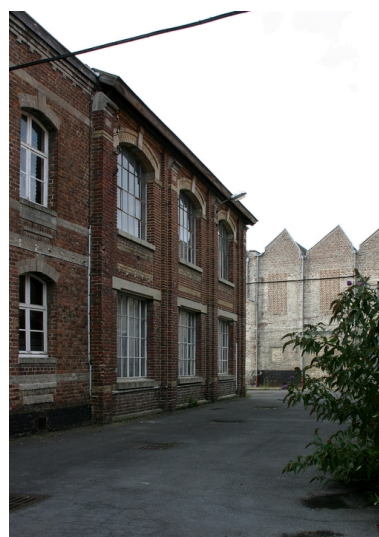
Pignon nord des bureaux. Phot. Frédéric Pillet IVR22_20040201042NUCA
