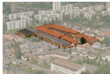
Vue aérienne de l'usine vers 1989. Phot. Pillet Frédéric IVR22_20050205128NUCAB
