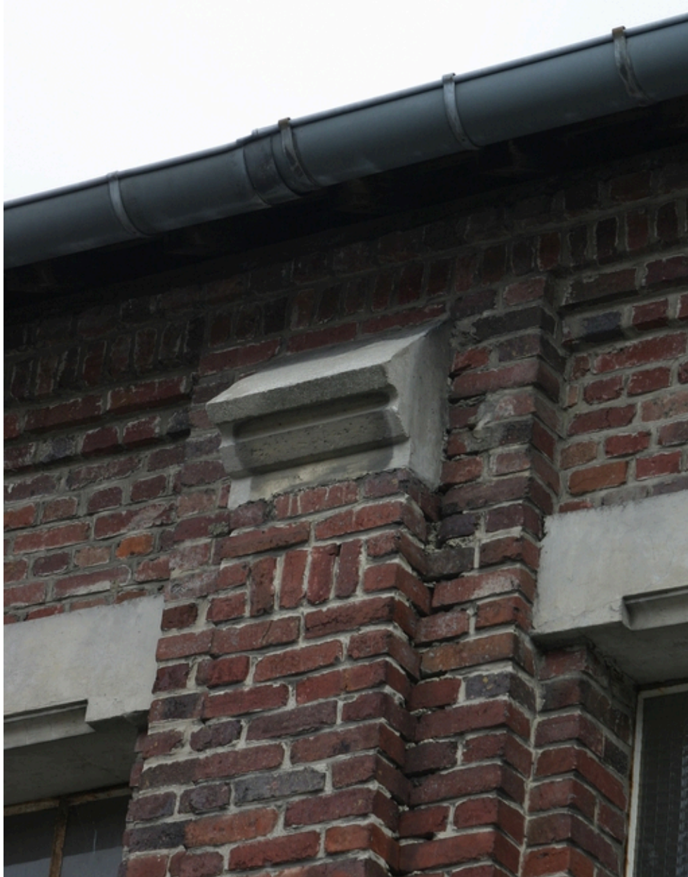
Façade occidentale de l'un des deux grands ateliers de guipure reconstruits à partir de 1919 : détail.
