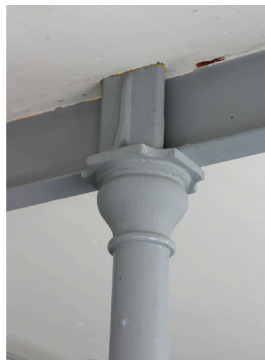
Ateliers antérieurs à 1900 (ensemble ouest) : chapiteau d'une colonne en fonte du rez-de-chaussée. Phot. Frédéric Pillet IVR22_20040201033NUCA
