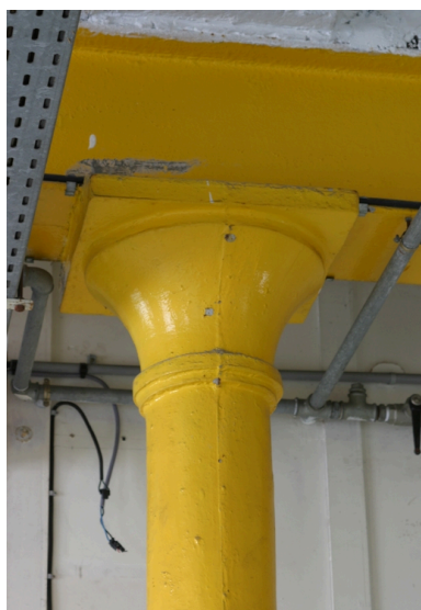
Ateliers antérieurs à 1900 (ensemble ouest) : chapiteau d'une colonne en fonte du rez-de-chaussée. Phot. Frédéric Pillet IVR22_20040201034NUCA
