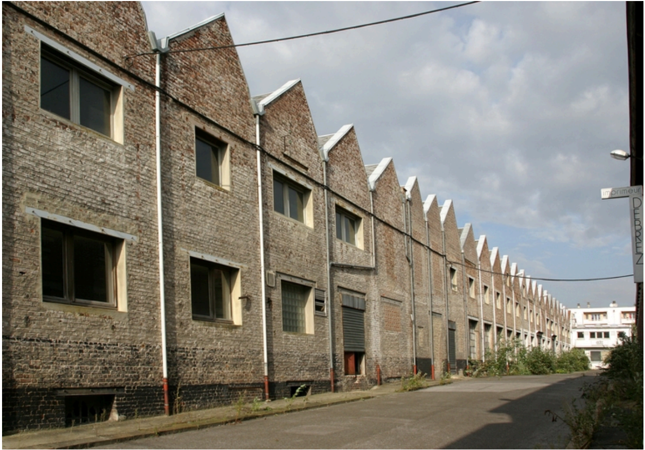
Façade orientale de l'un des deux ensembles d'ateliers (ateliers ouest) antérieurs à 1900.
