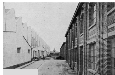
Des ateliers restaurés (à gauche) et reconstruits (à droite) en 1921 : aspect de la cour de la nouvelle usine vue de l'entrée (Le Monde Illustré). Phot. Pillet Frédéric IVR22_20040201014NUCAB
