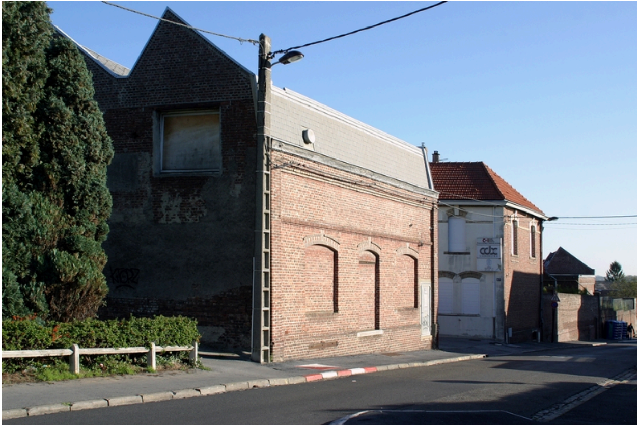
Entrée de l'usine.
