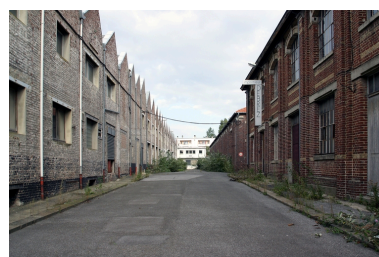
L'une des deux cours de l'usine : à gauche des ateliers du 19e siècle, à droite les bureaux et des ateliers reconstruits à partir de 1919. Phot. Frédéric Pillet IVR22_20040201027NUCA
