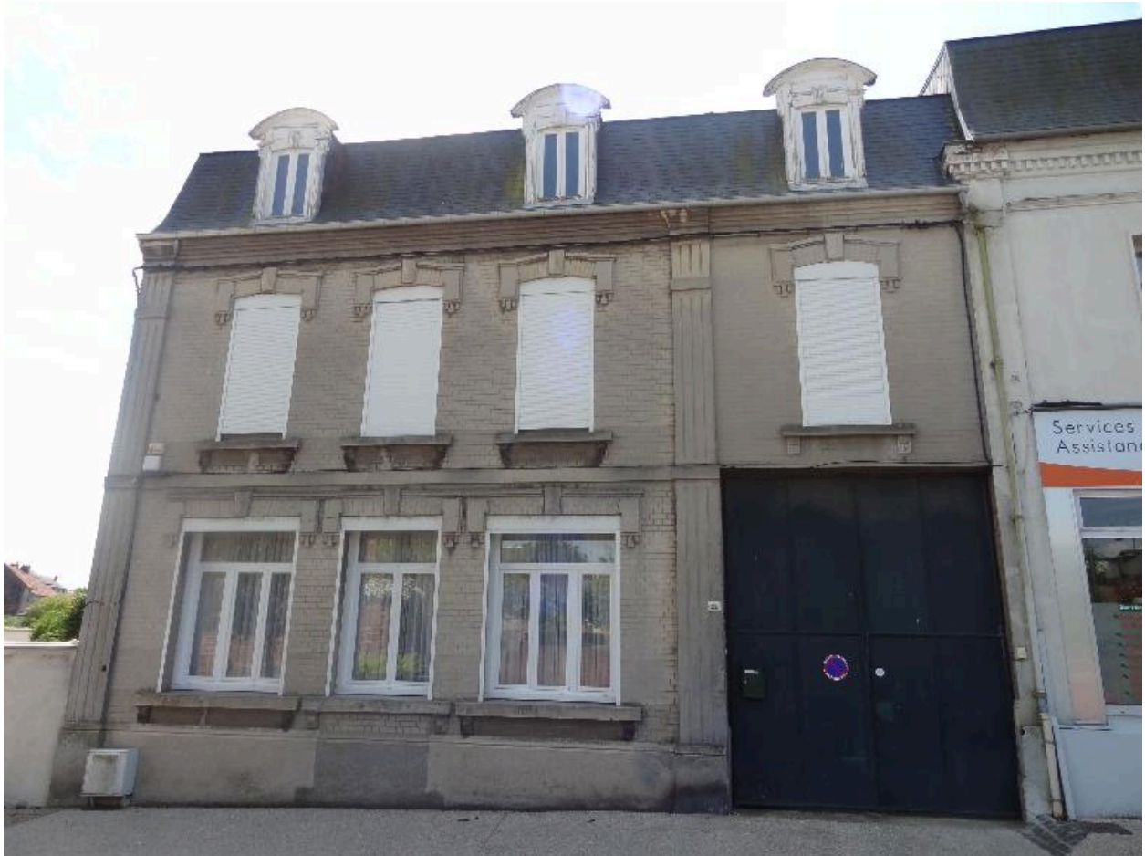
Ancien logement patronal.
