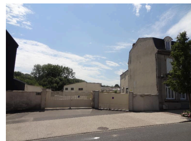
Vue des anciens ateliers de fabrication depuis la rue Camélinat.
