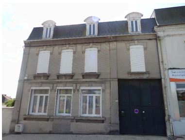
Ancien logement patronal.
