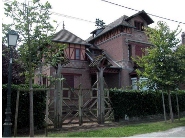
Vue d'ensemble depuis la digue. Phot. Elisabeth Justome IVR22_20038005413NUCA
