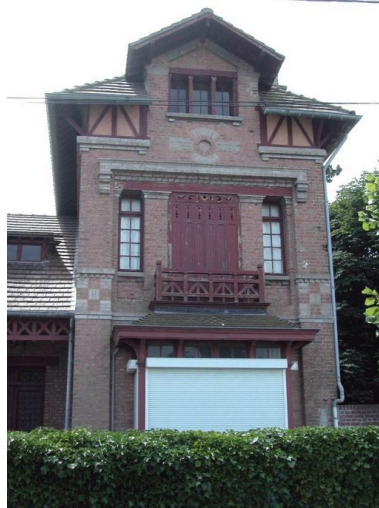
Détail de la travée en avancée. Phot. Elisabeth Justome IVR22_20038005414NUCA
