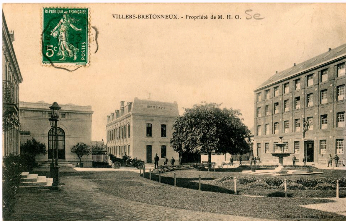
La filature Moirez-Outrequin. Villers-Bretonneux. Propriété de M. H. O. Carte postale, vers 1900 (coll. part. Drillancourt).
