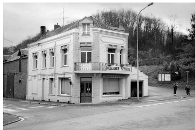
Vue des façades de la maison, à l'angle des rues de Vervins et du Général-de-Gaulle.
