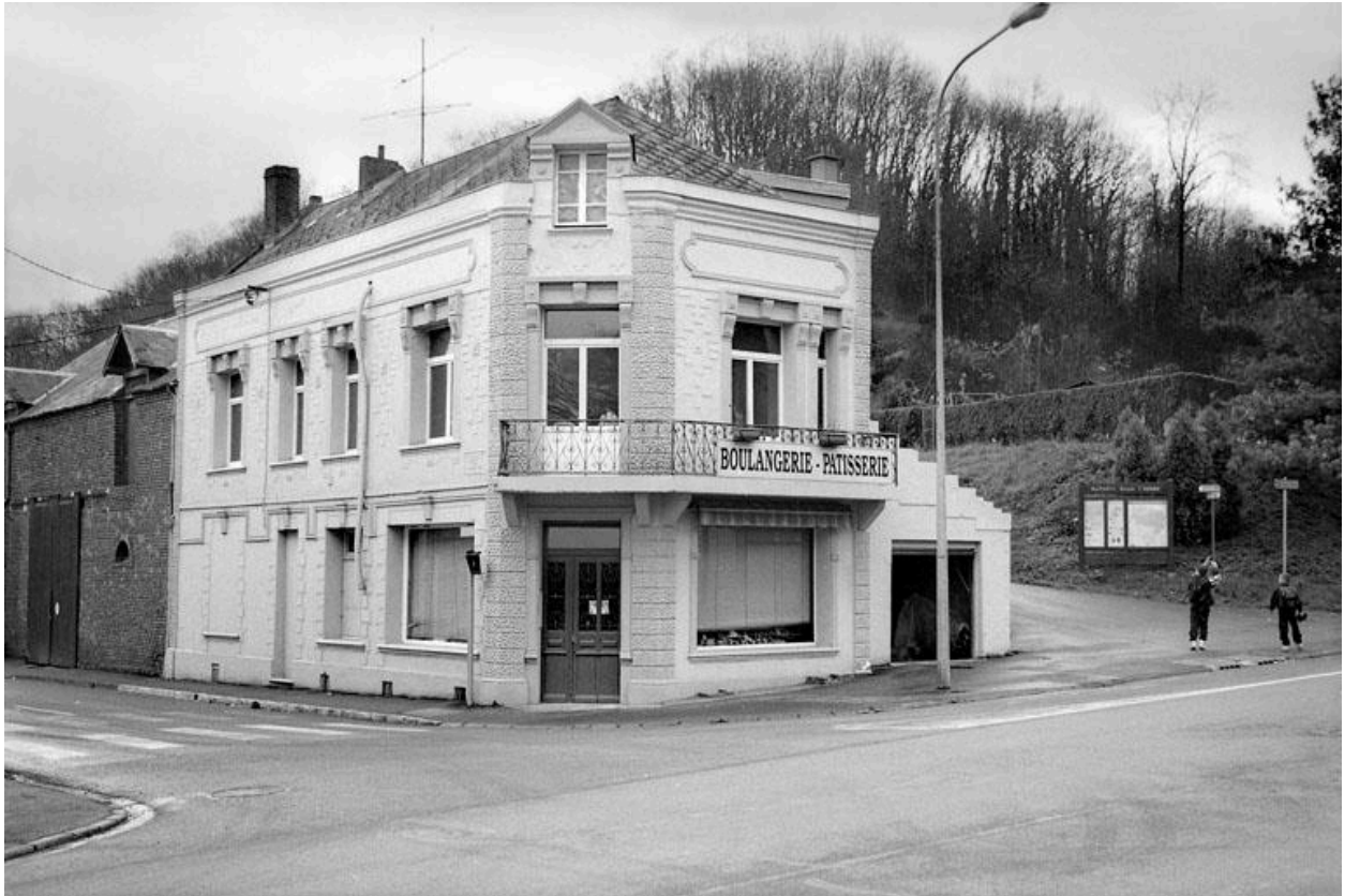
Vue des façades de la maison, à l'angle des rues de Vervins et du Général-de-Gaulle.
