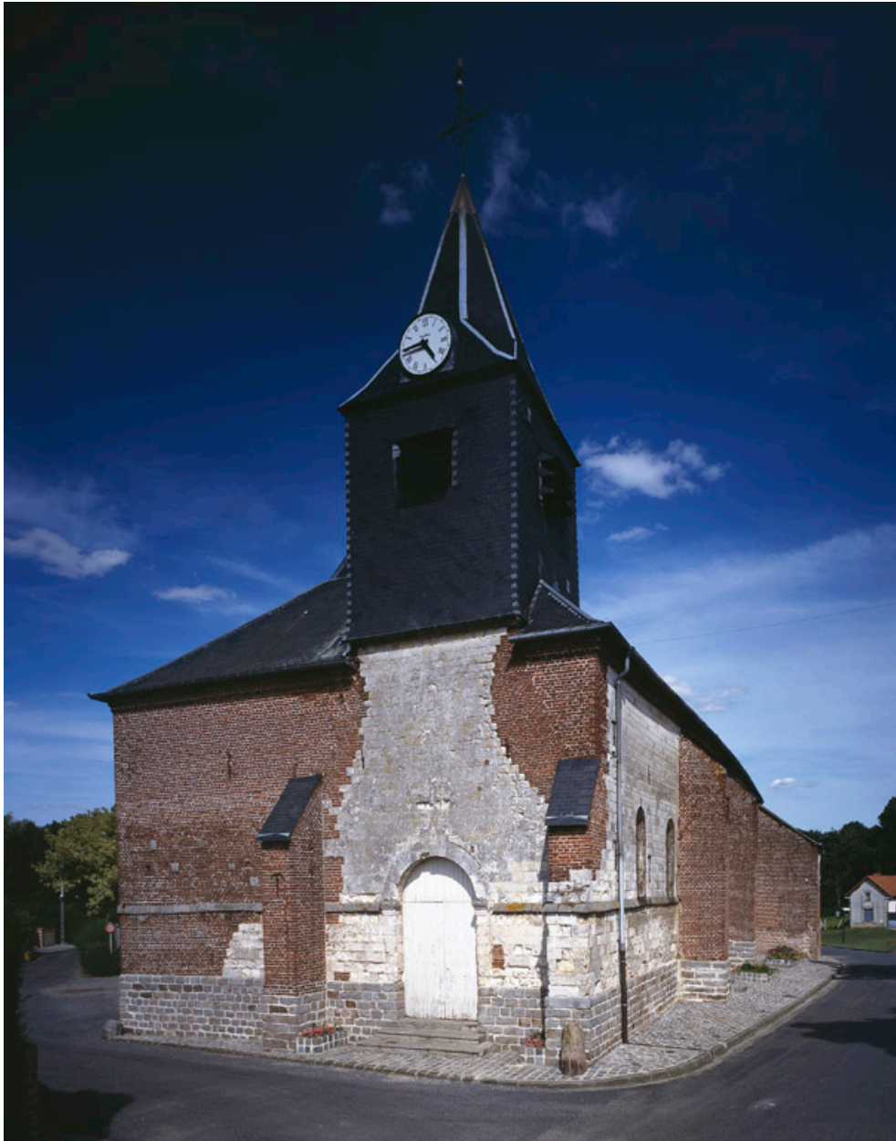
Vue de la façade occidentale.
