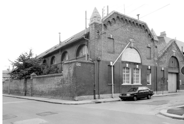
Vue générale depuis le sud. Phot. Benoît Dufournier IVR22_19918000239Z
