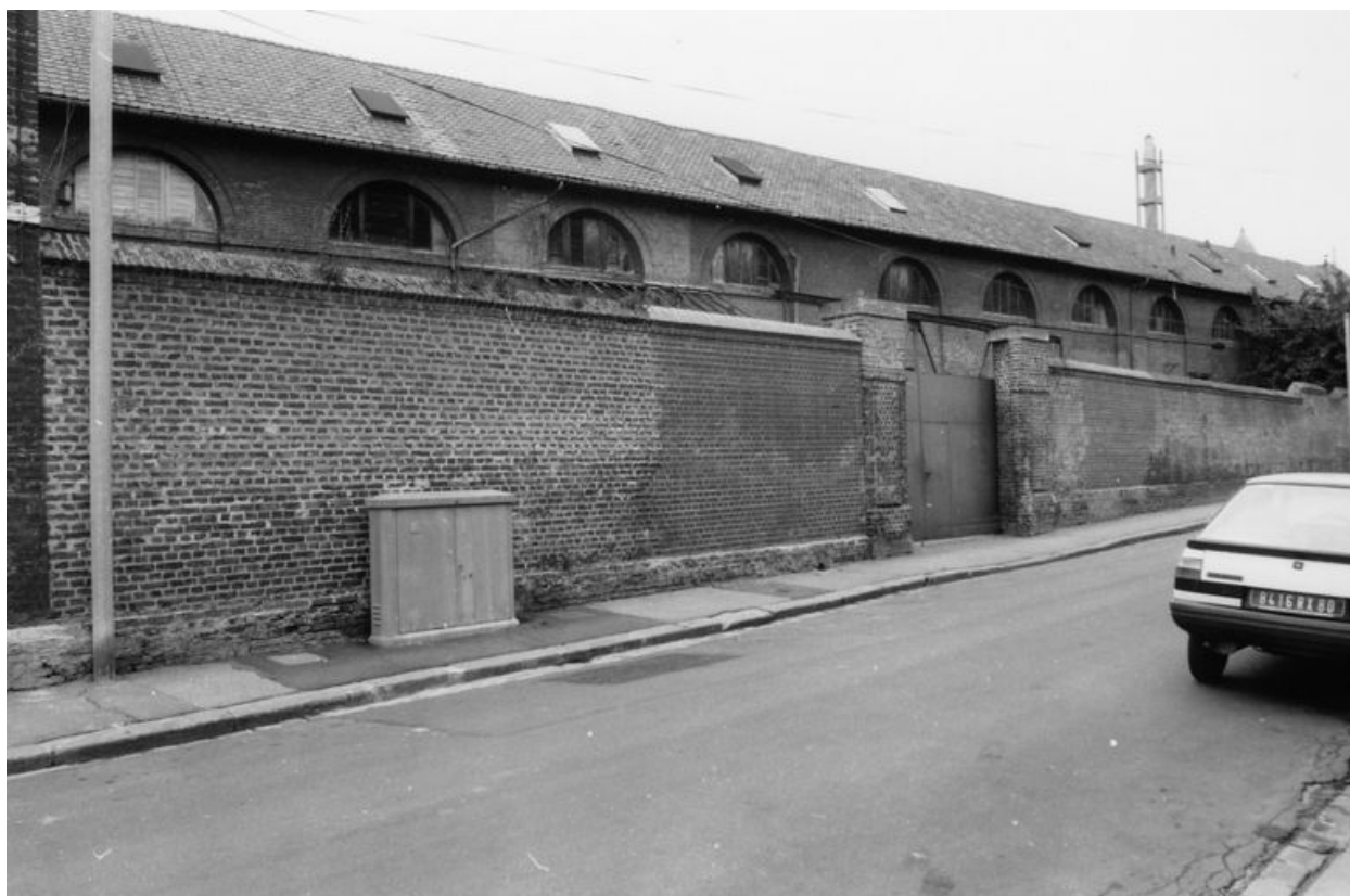
Ateliers de fabrication, flanc sud-ouest.
