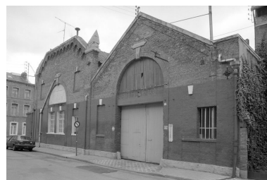
Atelier de fabrication et bureau. Phot. Benoît Dufournier IVR22_19918000237Z
