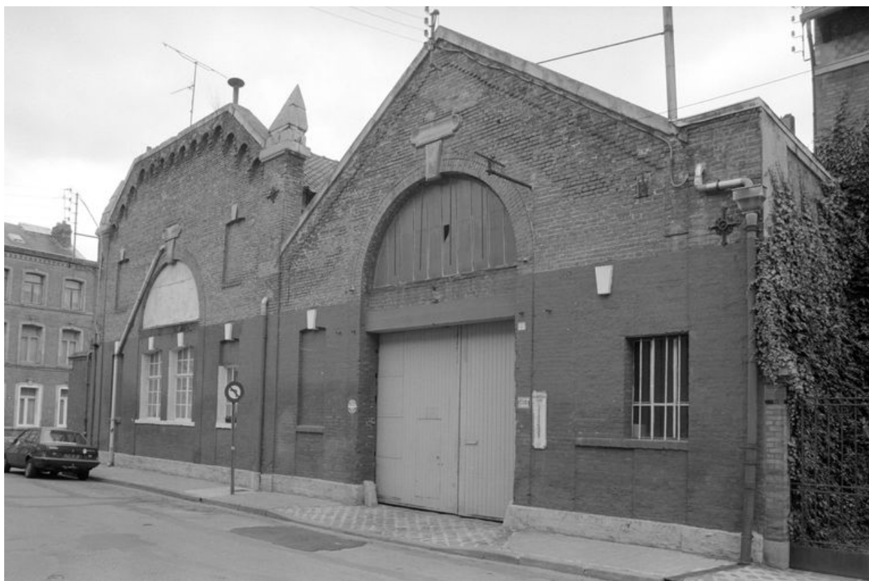
Atelier de fabrication et bureau.
