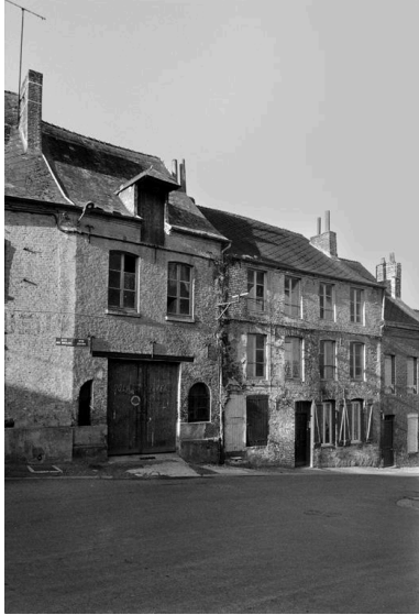
Vue de l'immeuble, depuis la rue des moulins. Phot. Pierre-Yves Brest IVR22_19990204350Z
