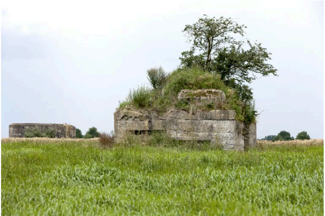
Vue générale depuis la route du Bas-Flandre, vers l'est (d'avant en arrière : IA59004842 et IA59004843)
