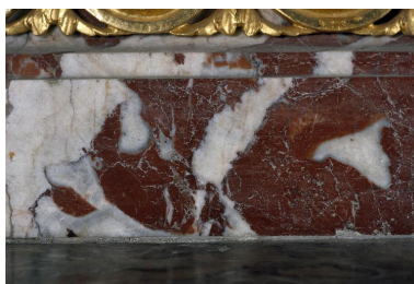
Détail du gradin d'autel en marbre de Rance. Phot. Irwin Leullier IVR22_20010202321ZA
