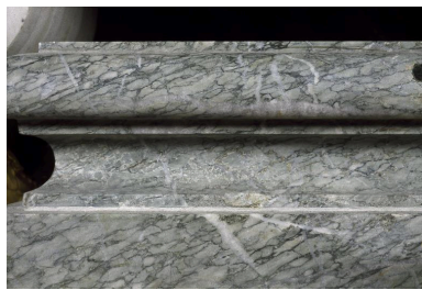
Détail du marbre de la face antérieure du tombeau de l'autel (Campan vert). Phot. Irwin Leullier IVR22_20010202324ZA
