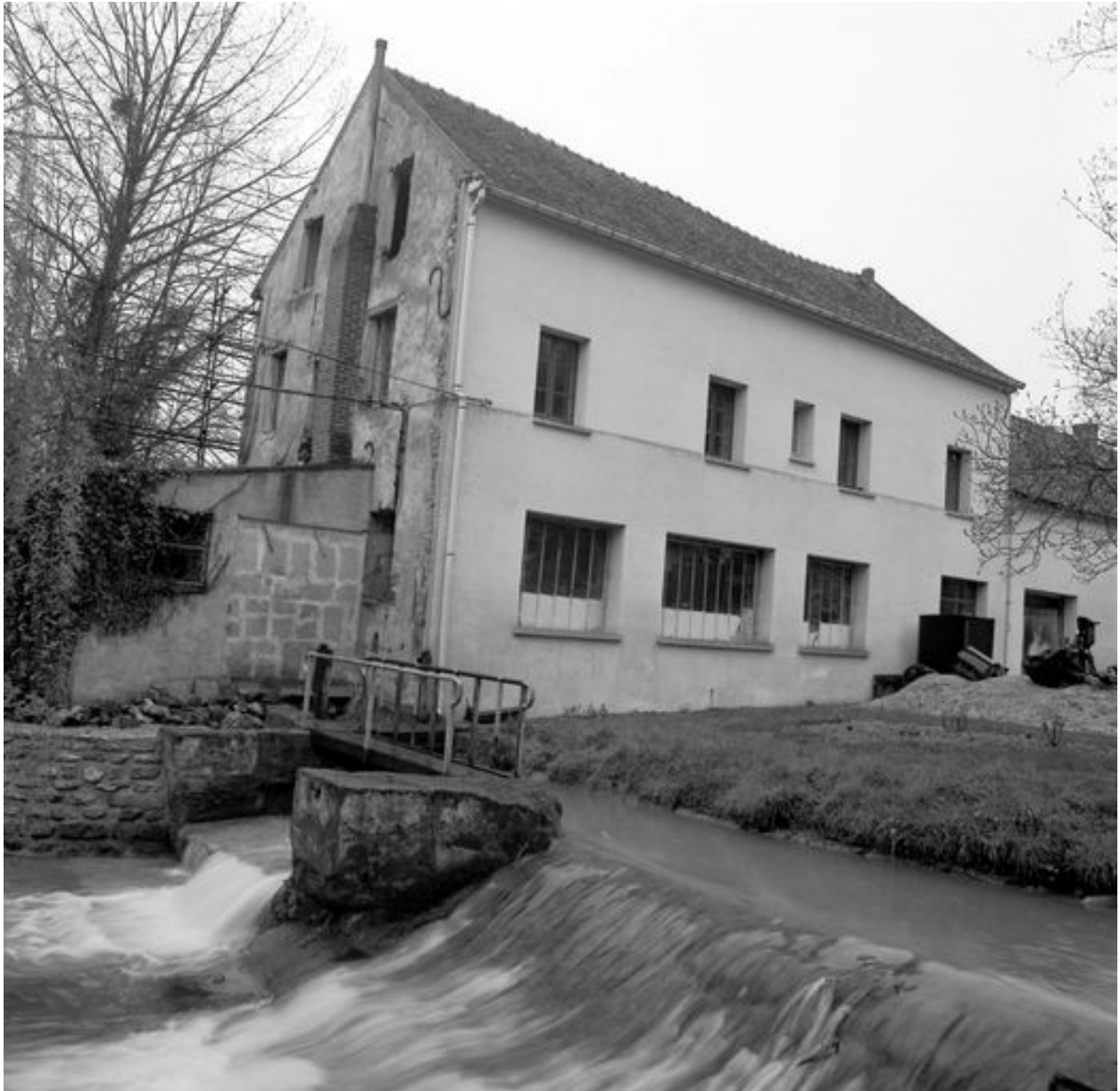
Façade ouest de l'atelier de fabrication avec la chute d'eau au premier plan.
