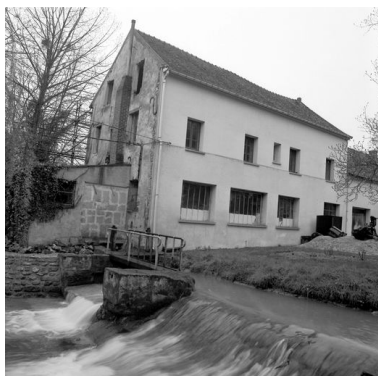
Façade ouest de l'atelier de fabrication avec la chute d'eau au premier plan. Phot. Thierry Lefébure IVR22_19986000121X
