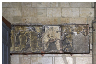
Vue partielle du 6e relief de l'ensemble. Phot. Thierry Lefébure IVR22_20100200067XA
