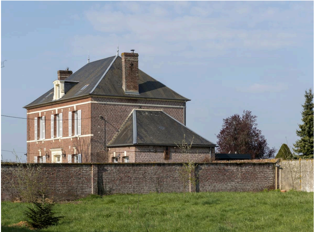
Logis d'une ancienne ferme, n°5 rue de l'Église, vue depuis le nord-est.
