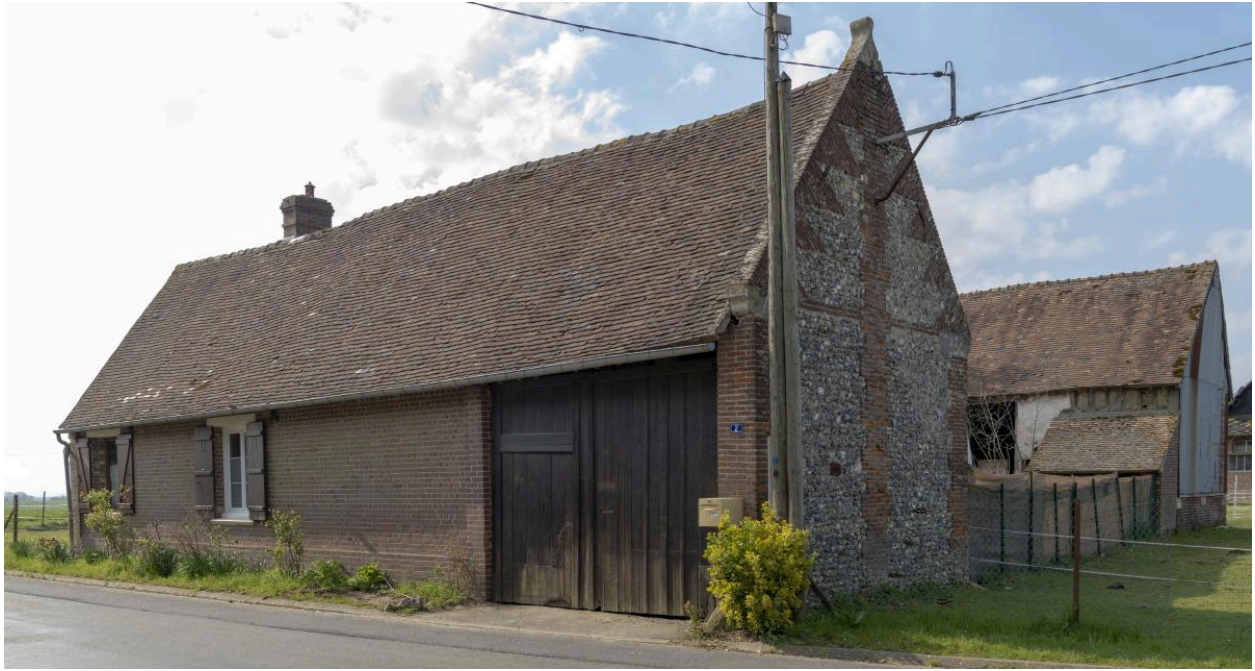
Ancienne ferme, n°2 rue Claude, vue depuis le nord-ouest.
