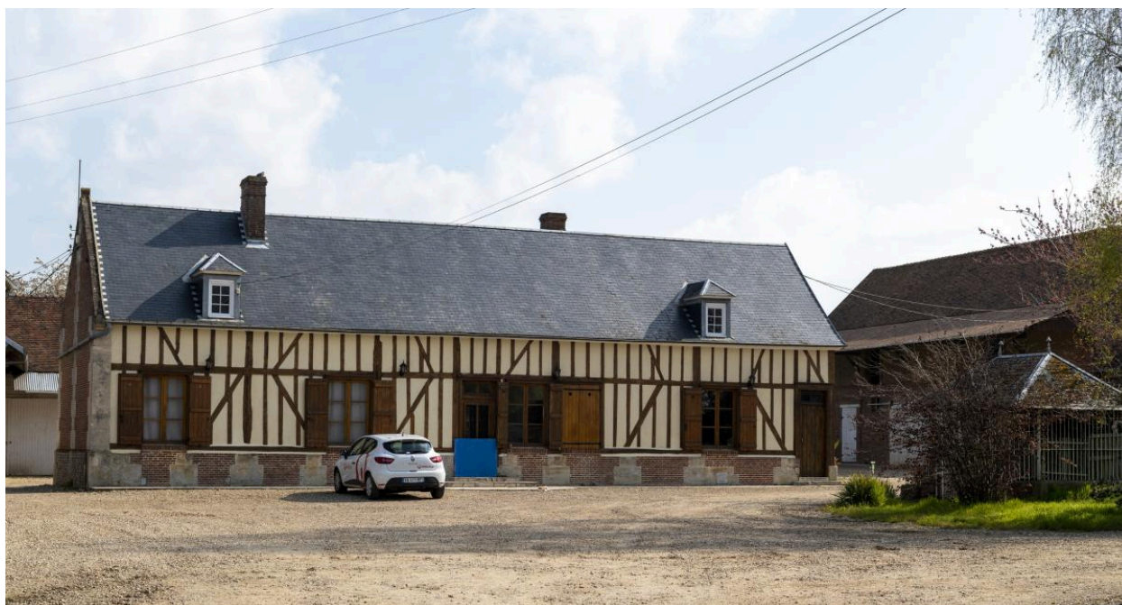
Logis de ferme, n°1 rue Claude, vue depuis le sud-ouest.
