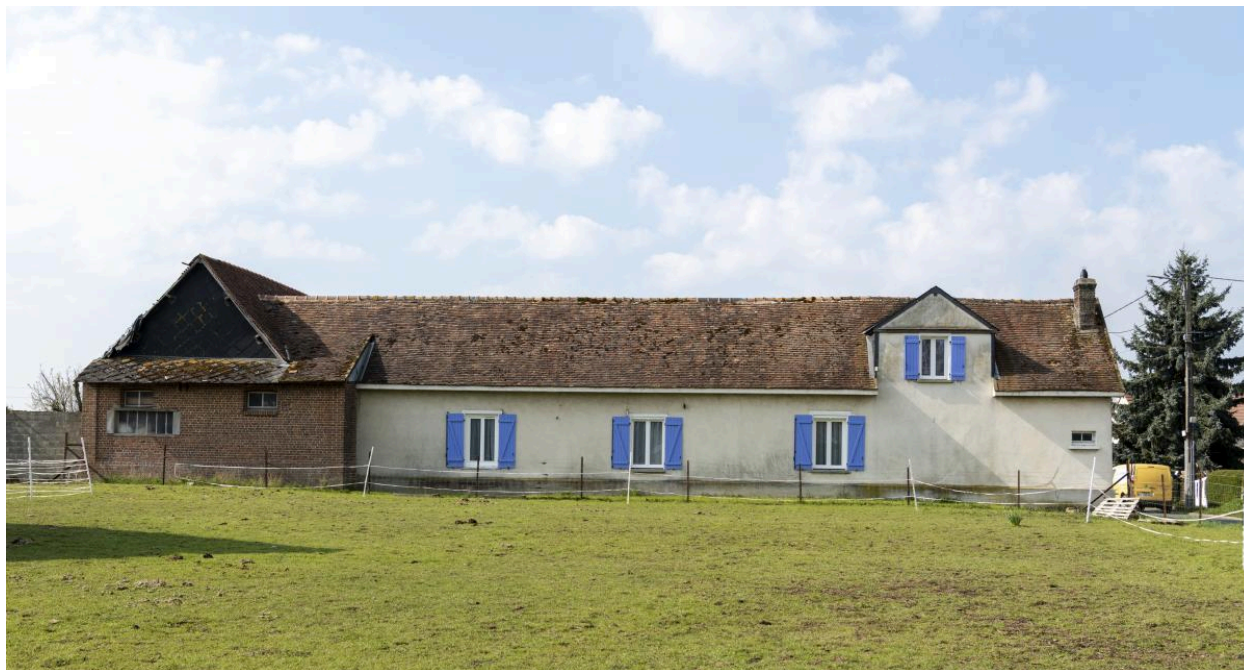
Logis d'une ancienne ferme, n°3 chemin Brunehaut, vue depuis le nord.
