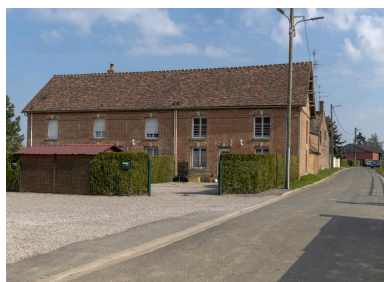
Logements, n°12B chemin Brunehaut, vue depuis le sud-est. Phot. Marc Kérignard IVR32_20216000258NUCA
