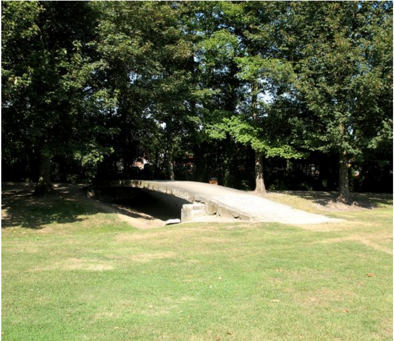
Vue du pont dans l'ancien parc du château.
