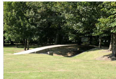
Ce pont est l'un des rares vestiges des aménagements du parc du château. Phot. Clarisse Lorieux IVR22_20096005134NUCA
