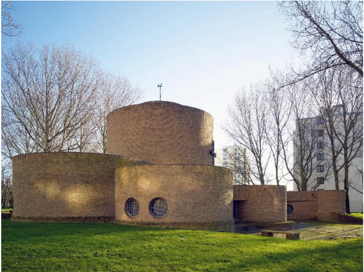
Élévation de la chapelle, côté nord ouest
