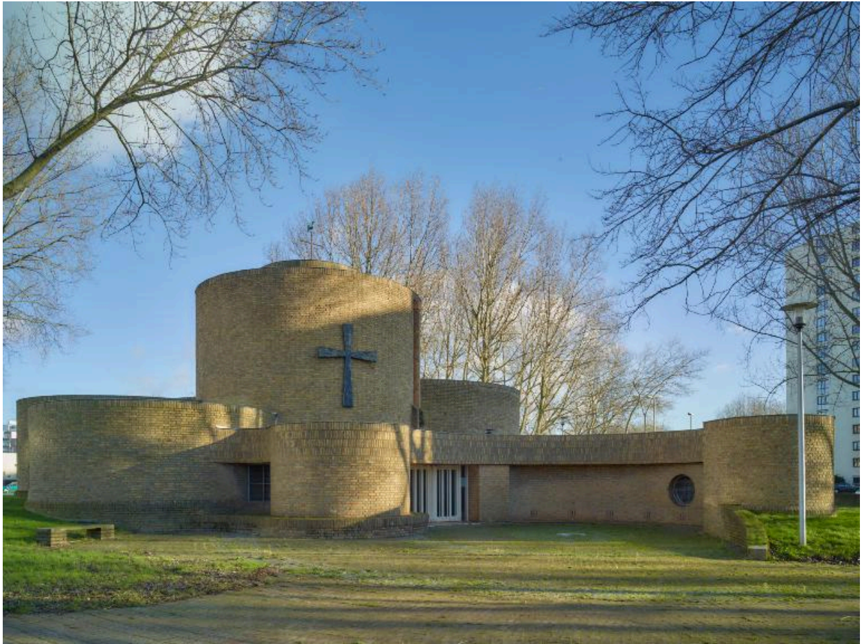
Élévation antérieure de la chapelle, côté sud ouest
