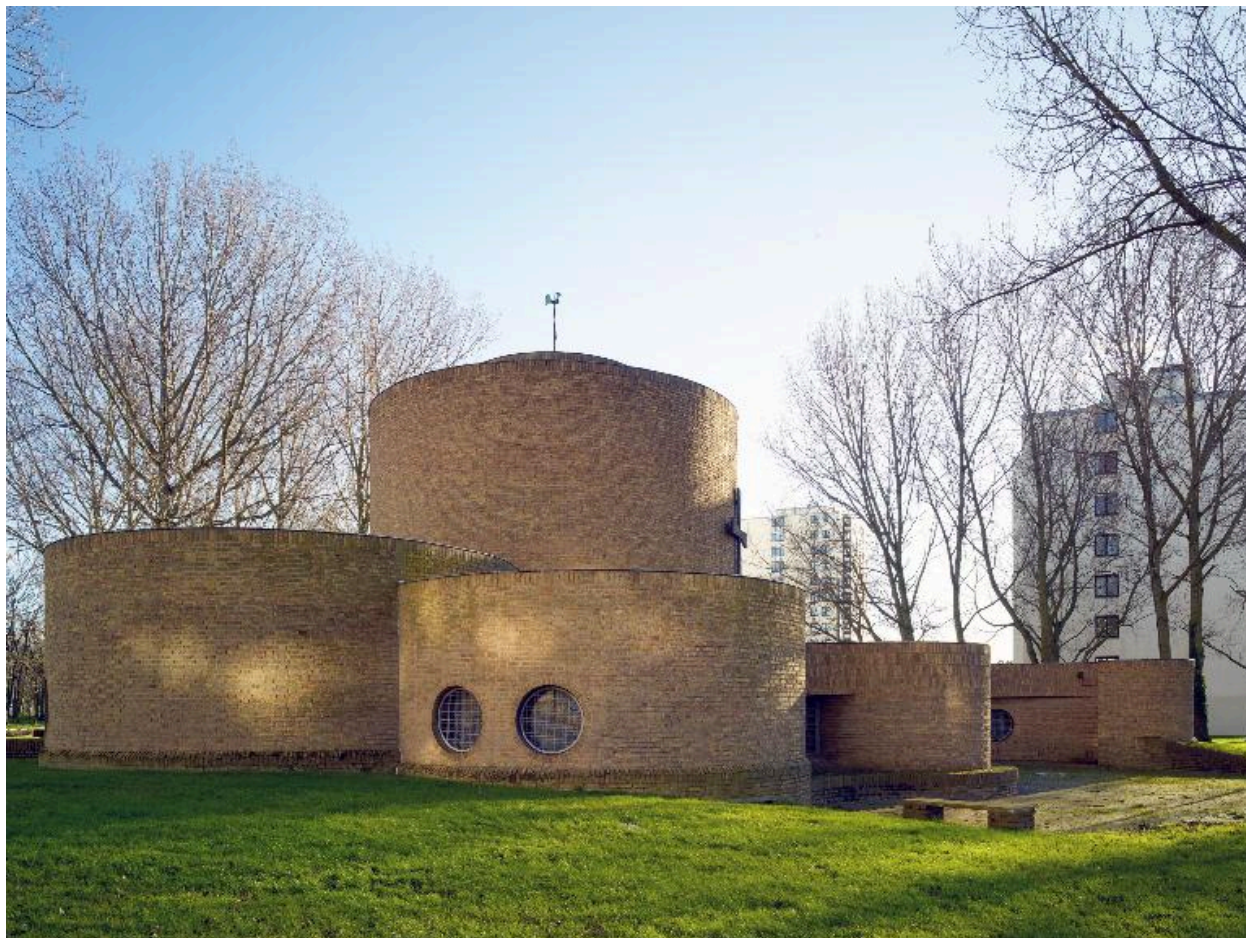
Élévation de la chapelle, côté nord ouest
