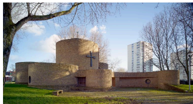
Élévation antérieure de la chapelle, côté ouest Phot. Pierre Thibaut IVR31_20155902100NUCA
