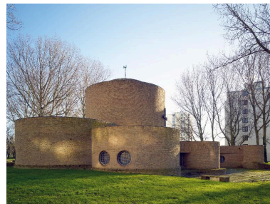
Élévation de la chapelle, côté nord ouest Phot. Pierre Thibaut IVR31_20155902077NUCA
