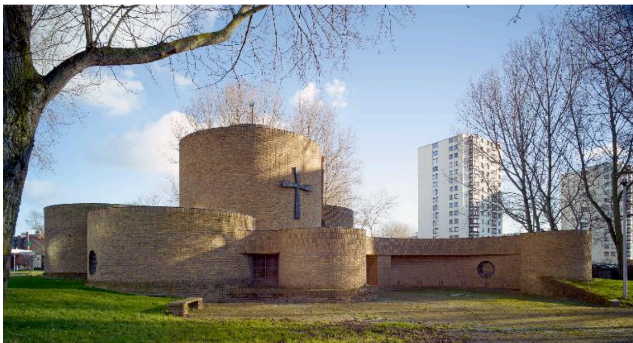
Élévation antérieure de la chapelle, côté ouest
