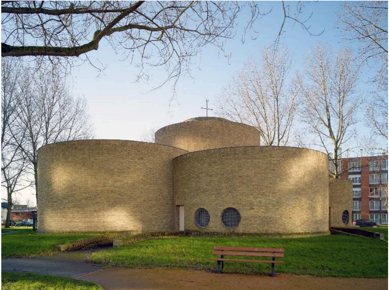
Élévation de la chapelle, côté nord
