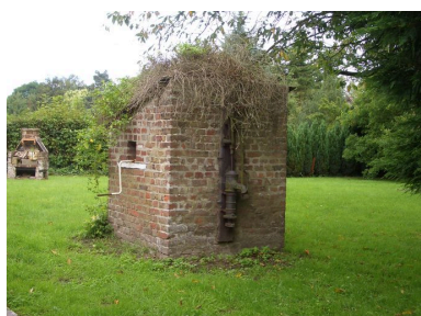
Vue du puits. Phot. Inès Guérin IVR22_20078005129NUCA
