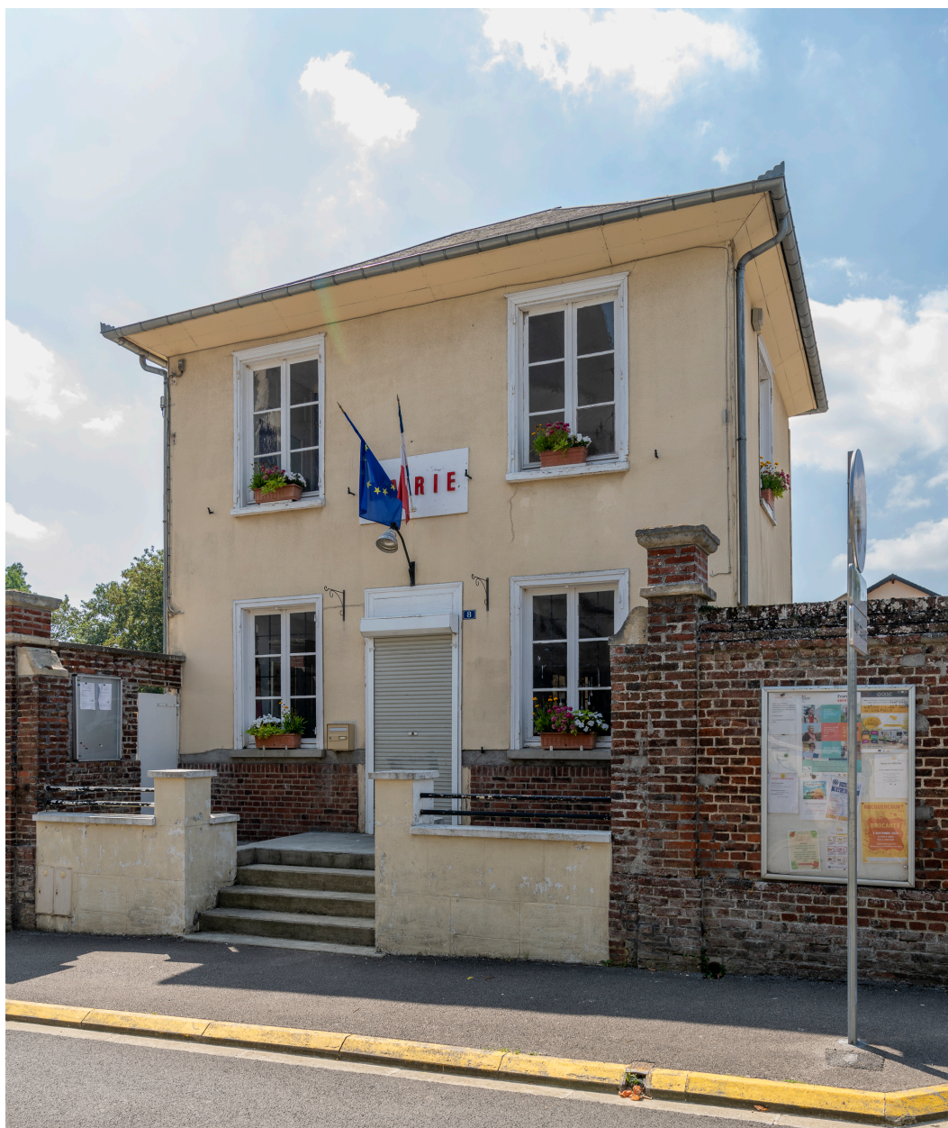
Mairie, vue prise depuis l'est.
