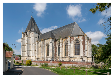
Église, vue prise depuis le sud-est.
