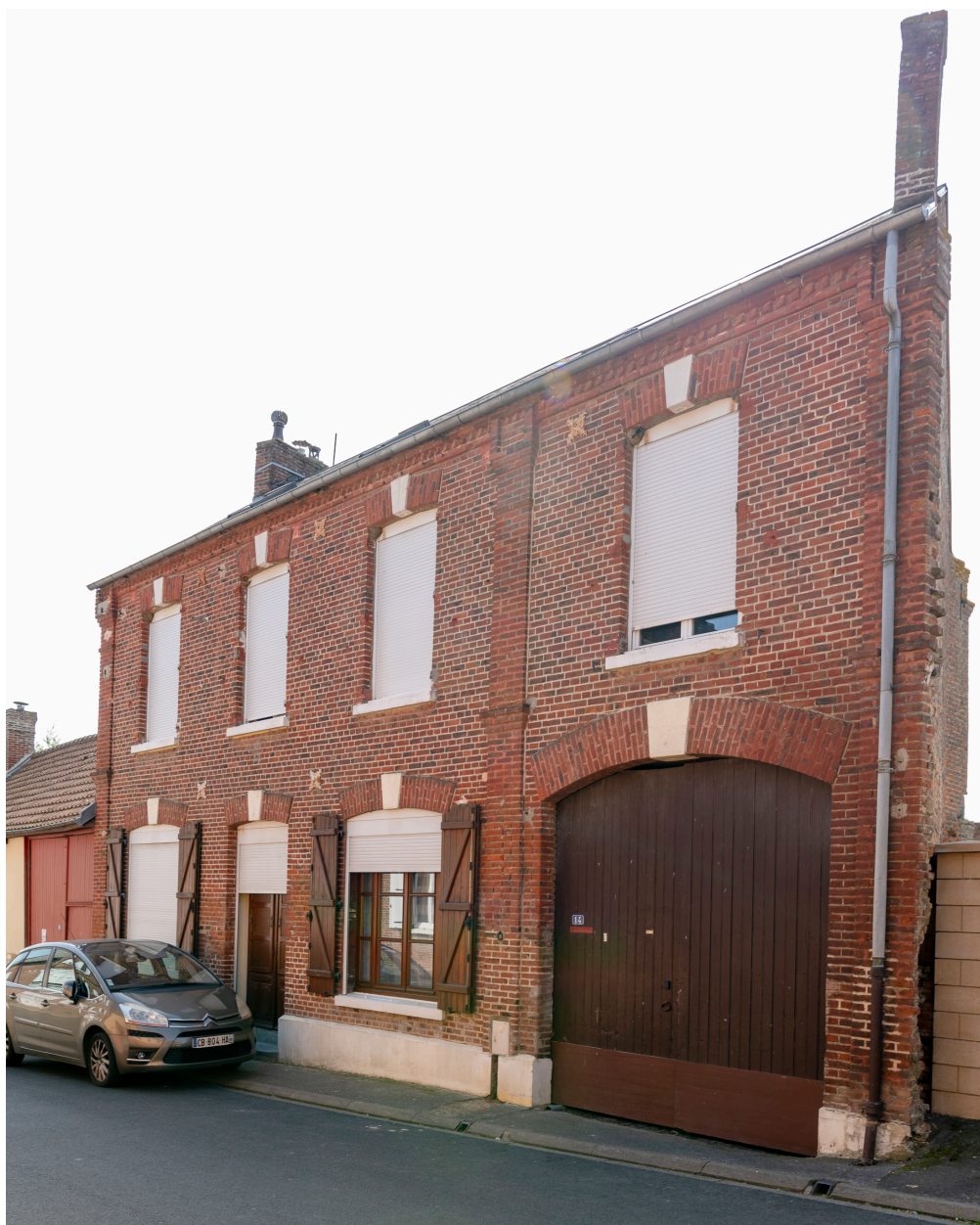
Ancien commerce, n°14 de la rue Roland-Mariage, vue prise depuis le nord.
