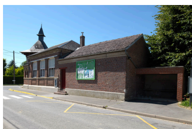
Vue des façades, rue d'Enfer. Phot. Marie-Laure Monnehay-Vulliet IVR22_20158000655NUC2A
