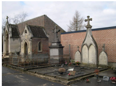
Vue générale en 2005, avant rénovation. Phot. Isabelle Barbedor IVR22_20058010077NUCA
