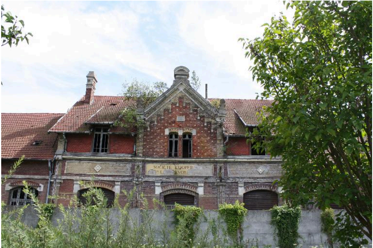
Vue partielle de la façade principale.
