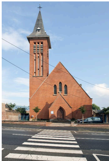
Élévation antérieure. Phot. Pierre Thibaut IVR31_20155900172NUCA
