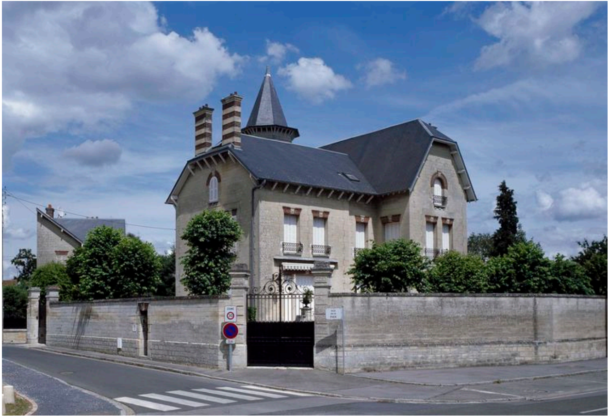
Vue générale de la maison du directeur.
