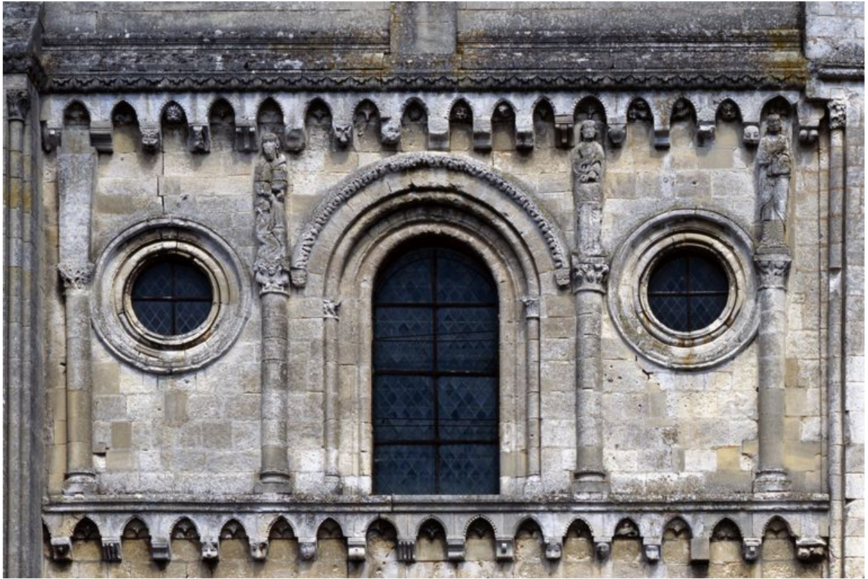
Deuxième niveau de la façade occidentale
