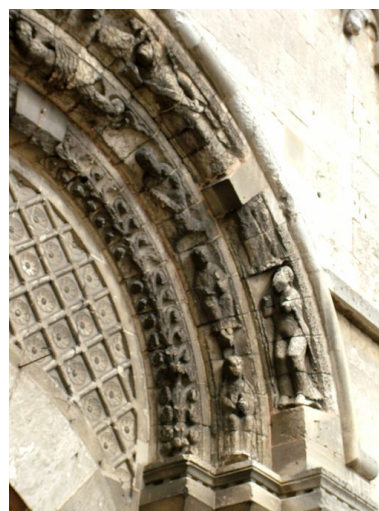
Détail de la voûsure du portail occidental : partie droite. Phot. Frédéric Fournis IVR22_20118001512NUCA
