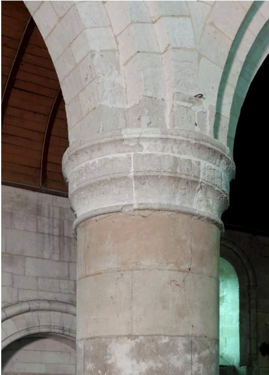
Chapiteau du troisième pilier cylindrique sud.
