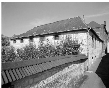
Vue, depuis la ruelle de la Tour, de l'élévation postérieure de la remise et de l'entrepôt de vin. Phot. Thierry Lefébure IVR22_19990205454V
