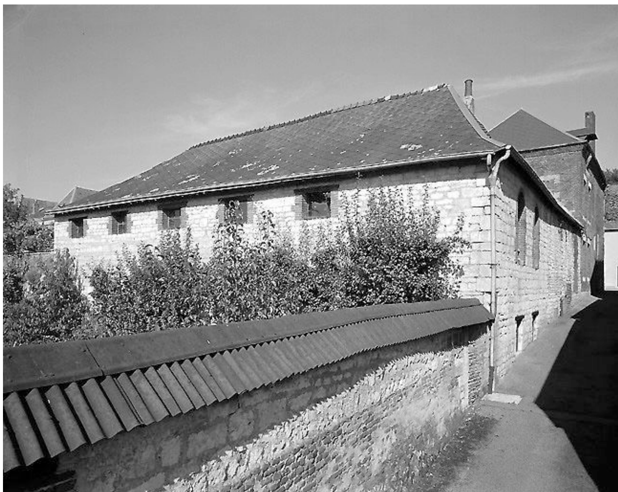
Vue, depuis la ruelle de la Tour, de l'élévation postérieure de la remise et de l'entrepôt de vin.
