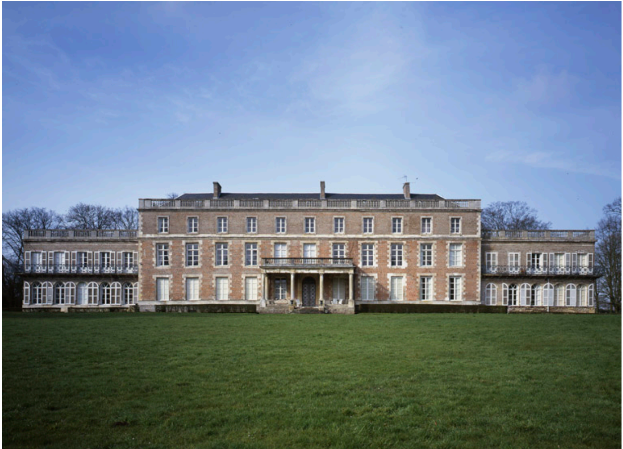
Le corps de logis : élévation orientale.
