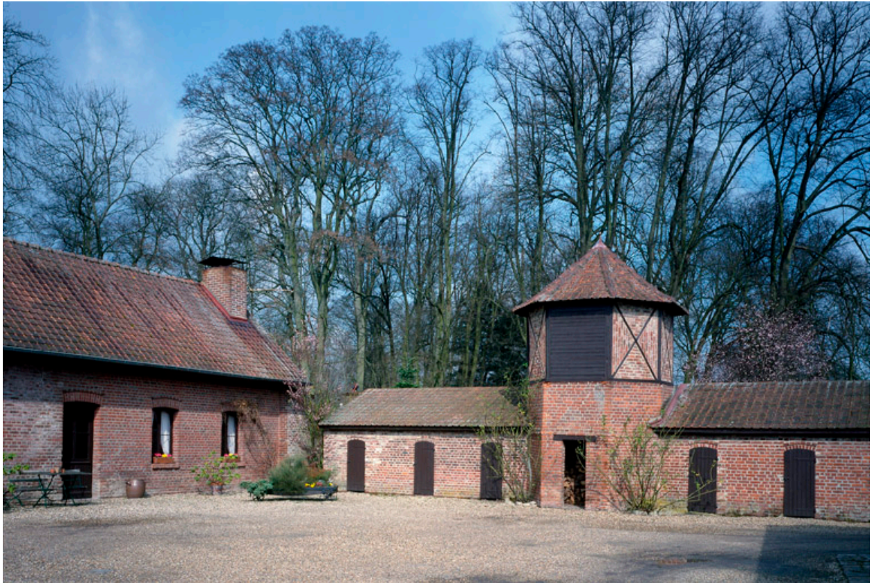
La ferme du château : vue du logis et des étables avec pigeonnier en briques.
