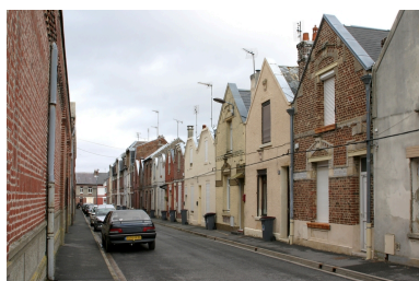
La rue de la Convention : à Gauche l'enceinte de l'usine, au fond à droite les logements. Phot. Frédéric Pillet IVR22_20060205086NUCA
