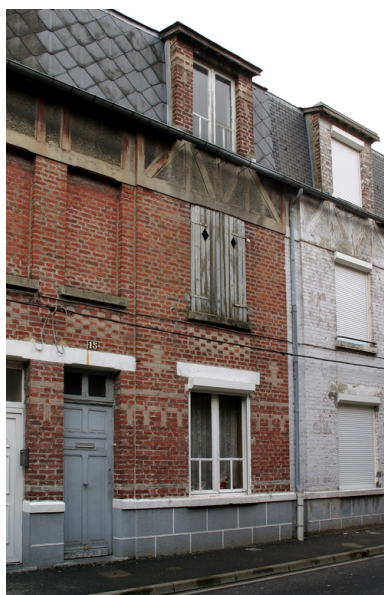
Façade de l'un des logements.
