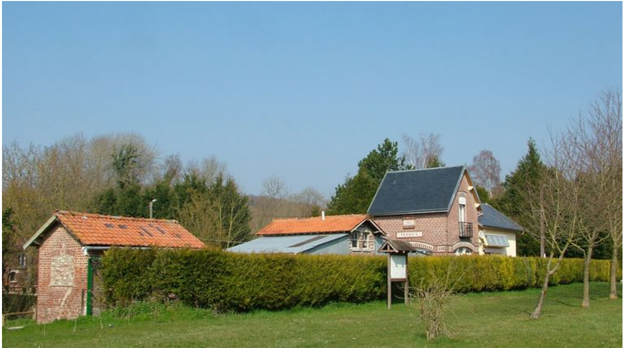
Ancienne gare, 21 rue du Pont-l'Évêque, datée de 1911 et complétée en 1925 (toilettes et lampisterie, buanderie).
