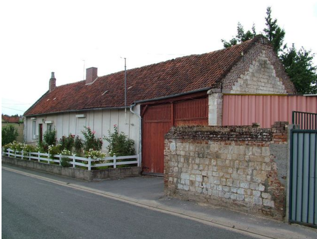
Maison, 287 rue d'En-Bas, 1er quart 19e siècle.
