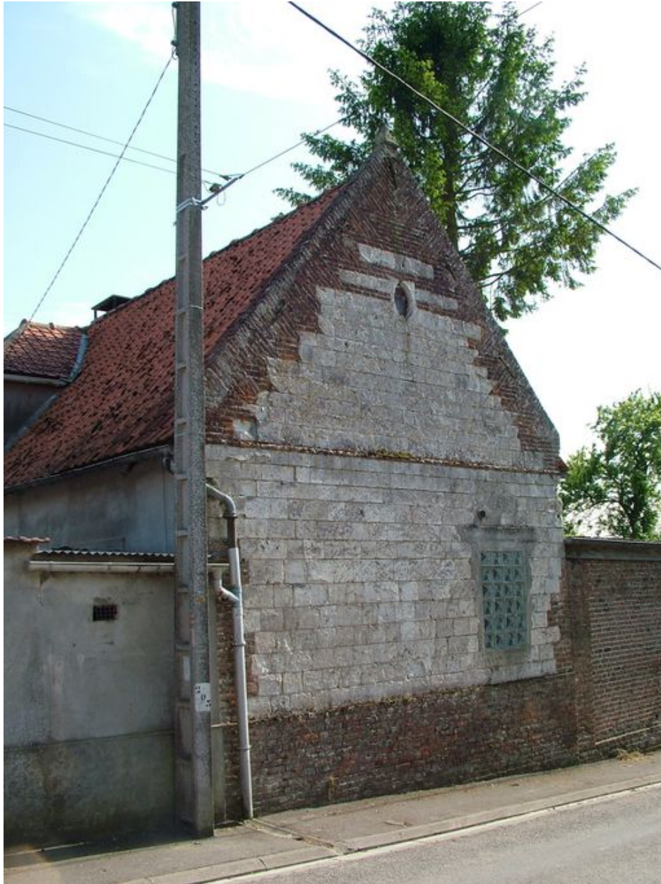
Pignon de l'ancien presbytère, 82 rue d'En-Haut, 18e siècle.
