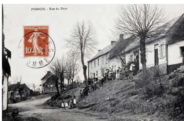
Rue du Haut, avant 1914 (coll. part.). Repro. Monnehay-Vulliet Marie-Laure IVR22_20108000078XA
