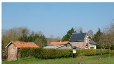
Ancienne gare, 21 rue du Pont- l'Evêque, datée de 1911 et complétée en 1925 (toilettes et lampisterie, buanderie). Phot. Frédéric Fournis IVR22_20098005424NUCA
