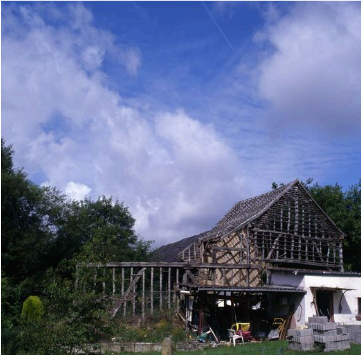
Grange de la ferme, 322 rue d'En-Haut, en cours de démolition.
