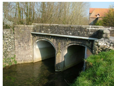
Pont sur la Nièvre au hameau du Soudet, 1ère moitié 19e siècle. Phot. Frédéric Fournis IVR22_20098005081NUCA
