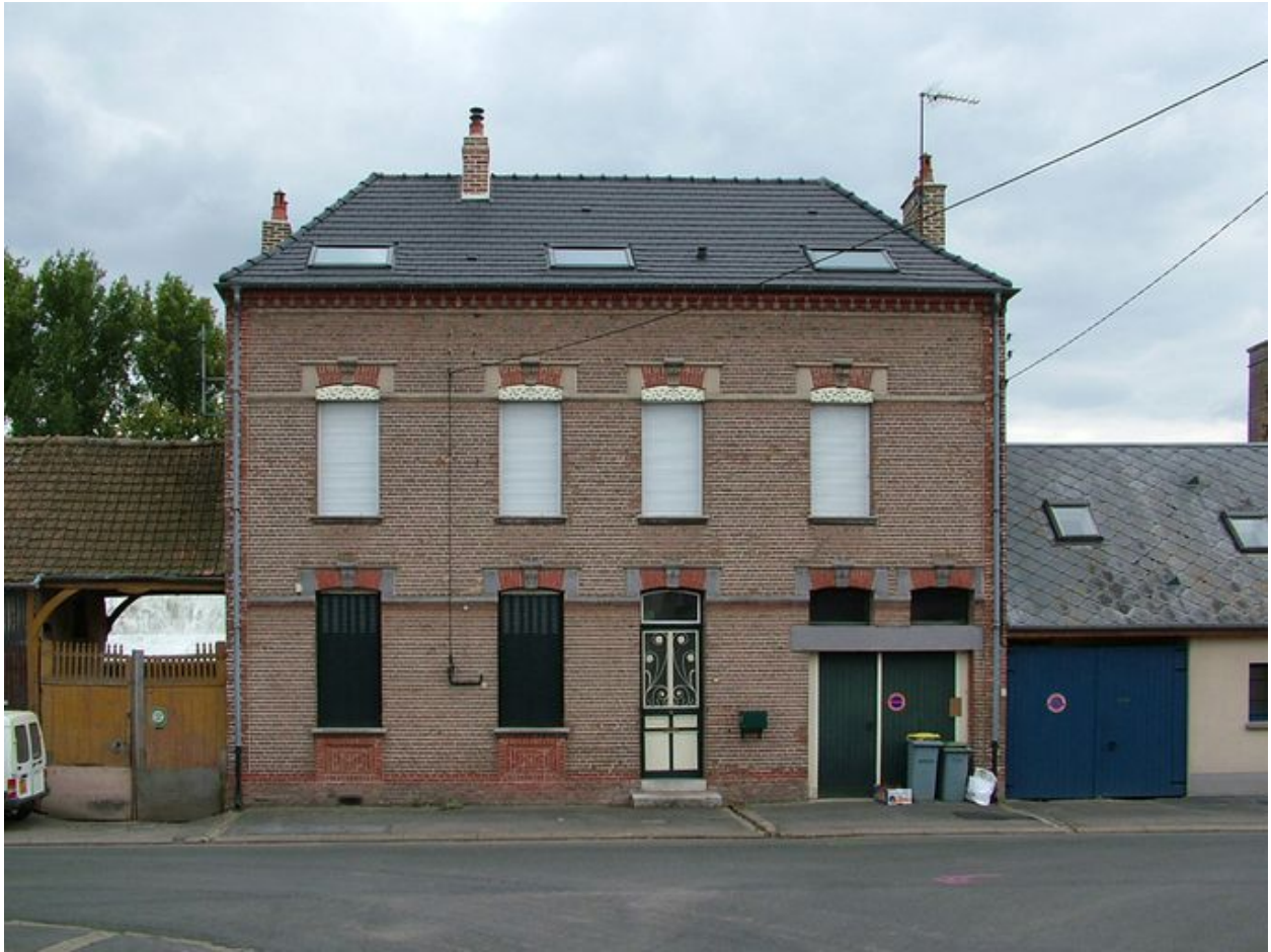
Maison, 168 rue de la Ville, 1e quart 20e siècle.
