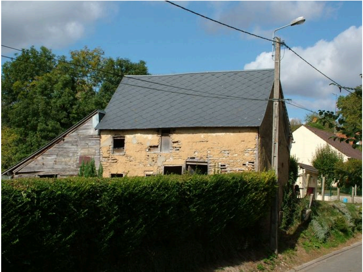
Grange en torchis, rue du Pont-l'Evêque, milieu 19e siècle.
