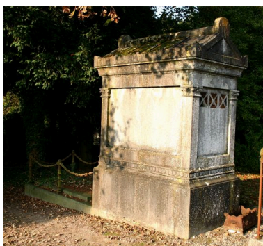
Vue générale postérieure. Phot. Caroline Vincent IVR22_20088000711NUCA
