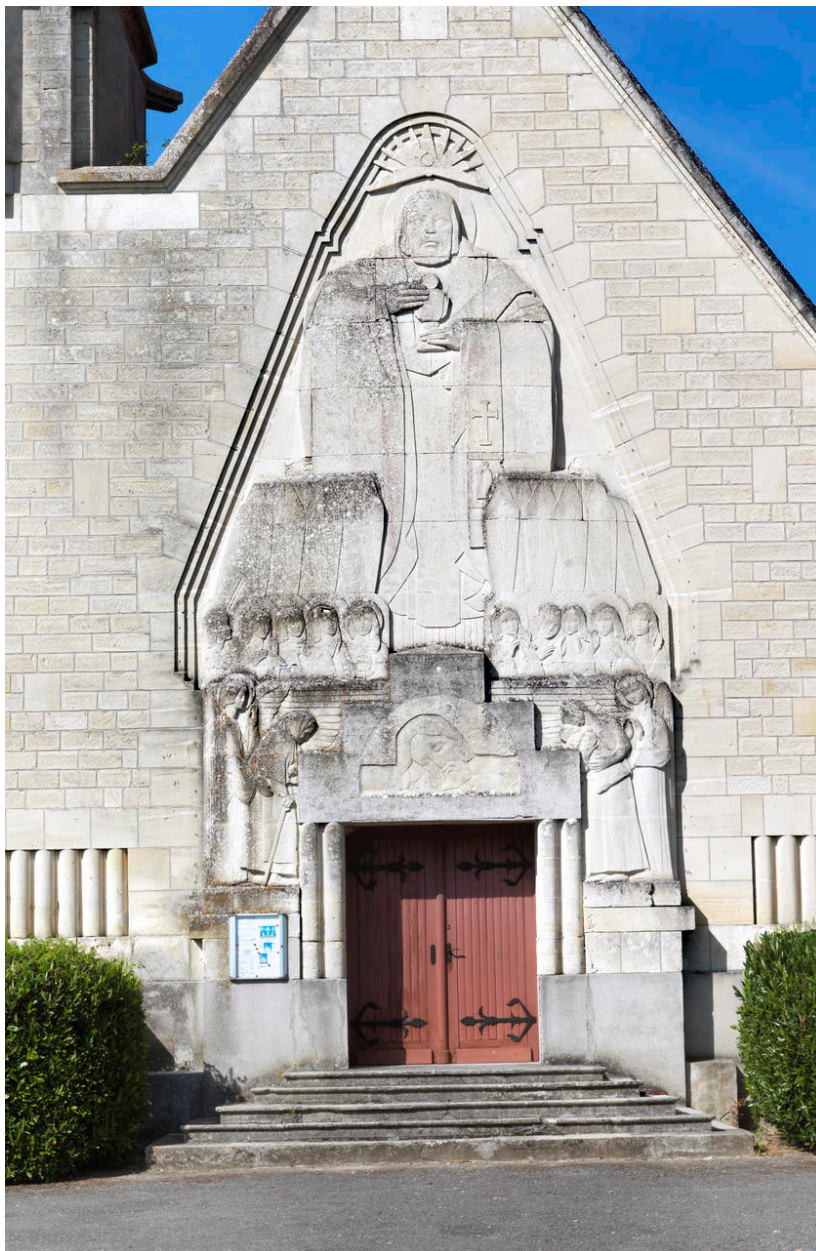
Vue du décor sculpté de la façade : la messe de saint Martin.
