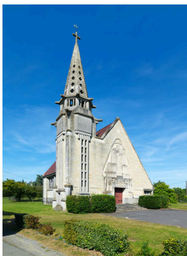
Vue générale depuis le sud-ouest. Phot. Thierry Lefébure IVR32_20210200197NUCA
