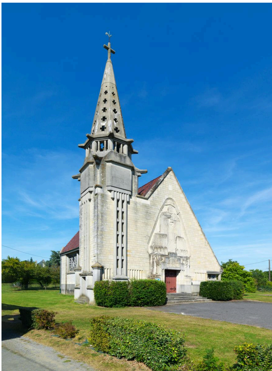
Vue générale depuis le sud-ouest.
