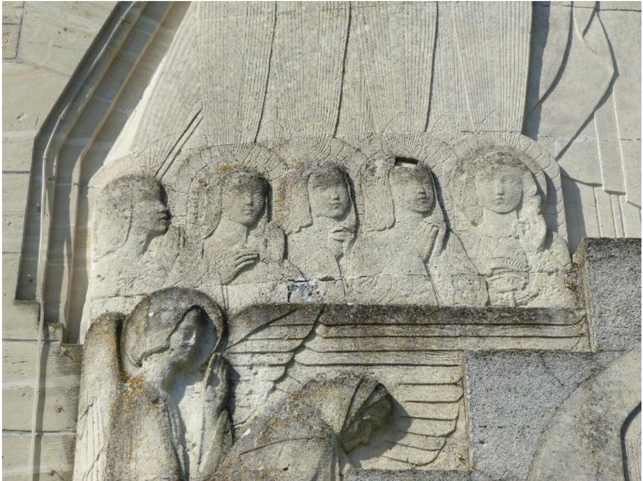
Détail du décor sculpté de la façade : partie gauche.
