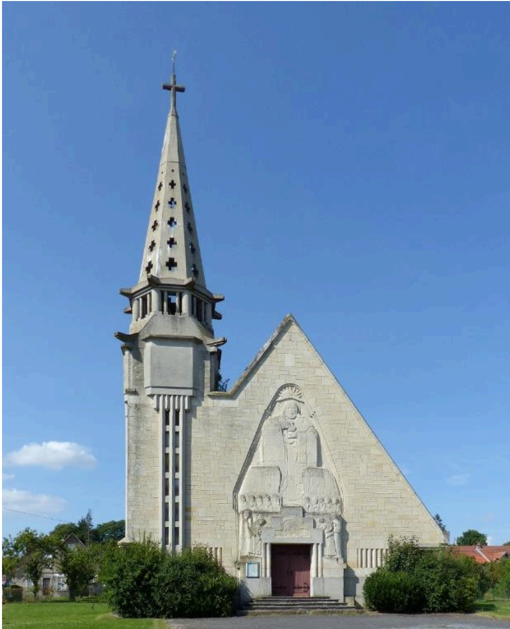
Vue générale, depuis le sud.
