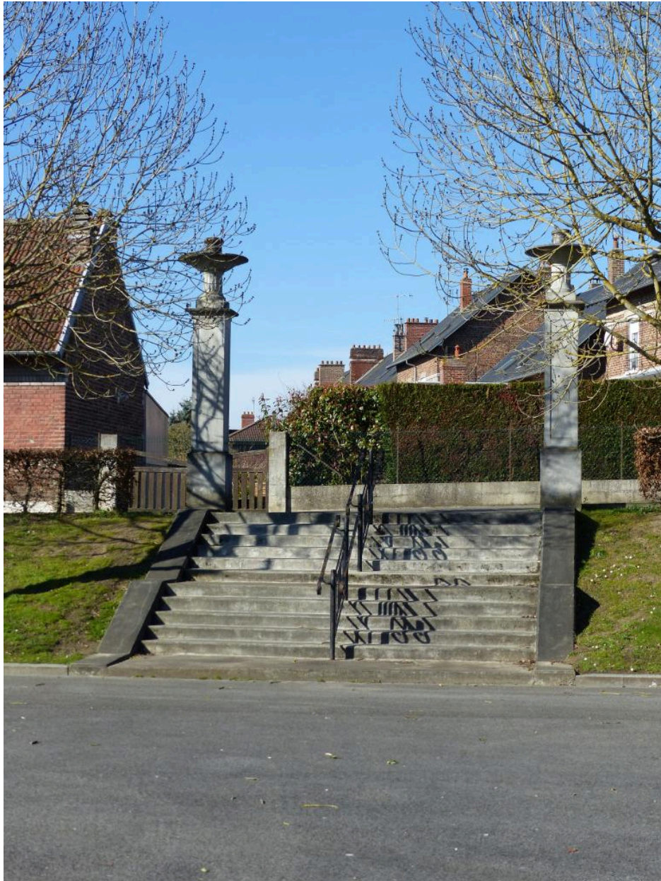
L'escalier de l'accès secondaire depuis la rue de la Place.
