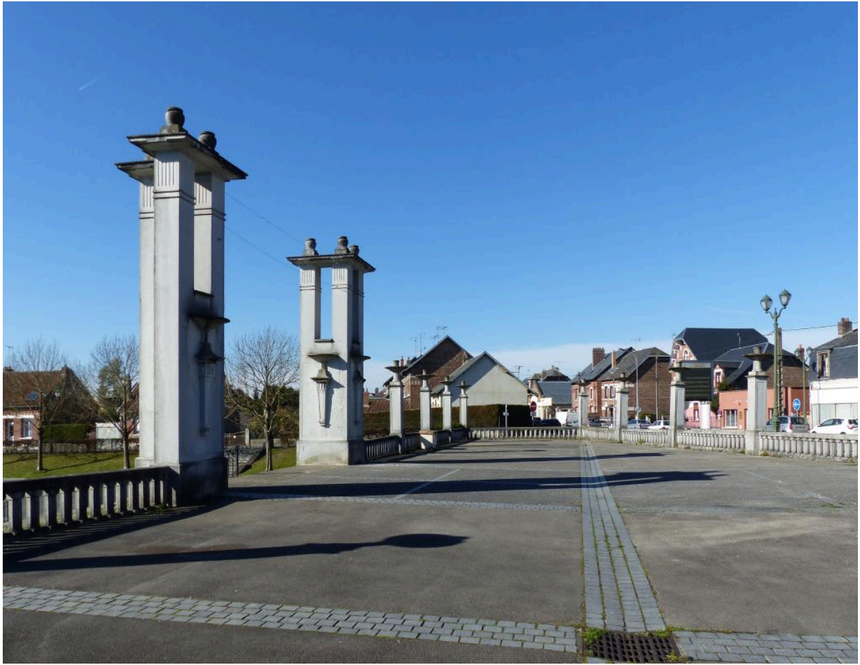
Le parvis, avenue Jean-Jaurès.
