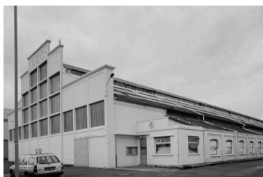
Atelier de fabrication : flanc sud-ouest. Phot. Benoît Dufournier IVR22_19936002459Z
