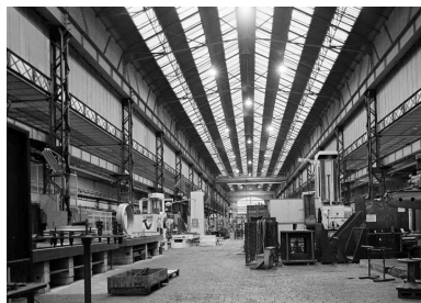
Atelier de fabrication principal : vue intérieure. Phot. Benoît Dufournier IVR22_19936002463Z
