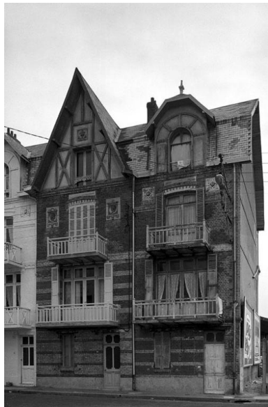
Vue d'ensemble des façades des n° 4 et 6 en 1981. Phot. Eric Dessert IVR31_19816203630X
