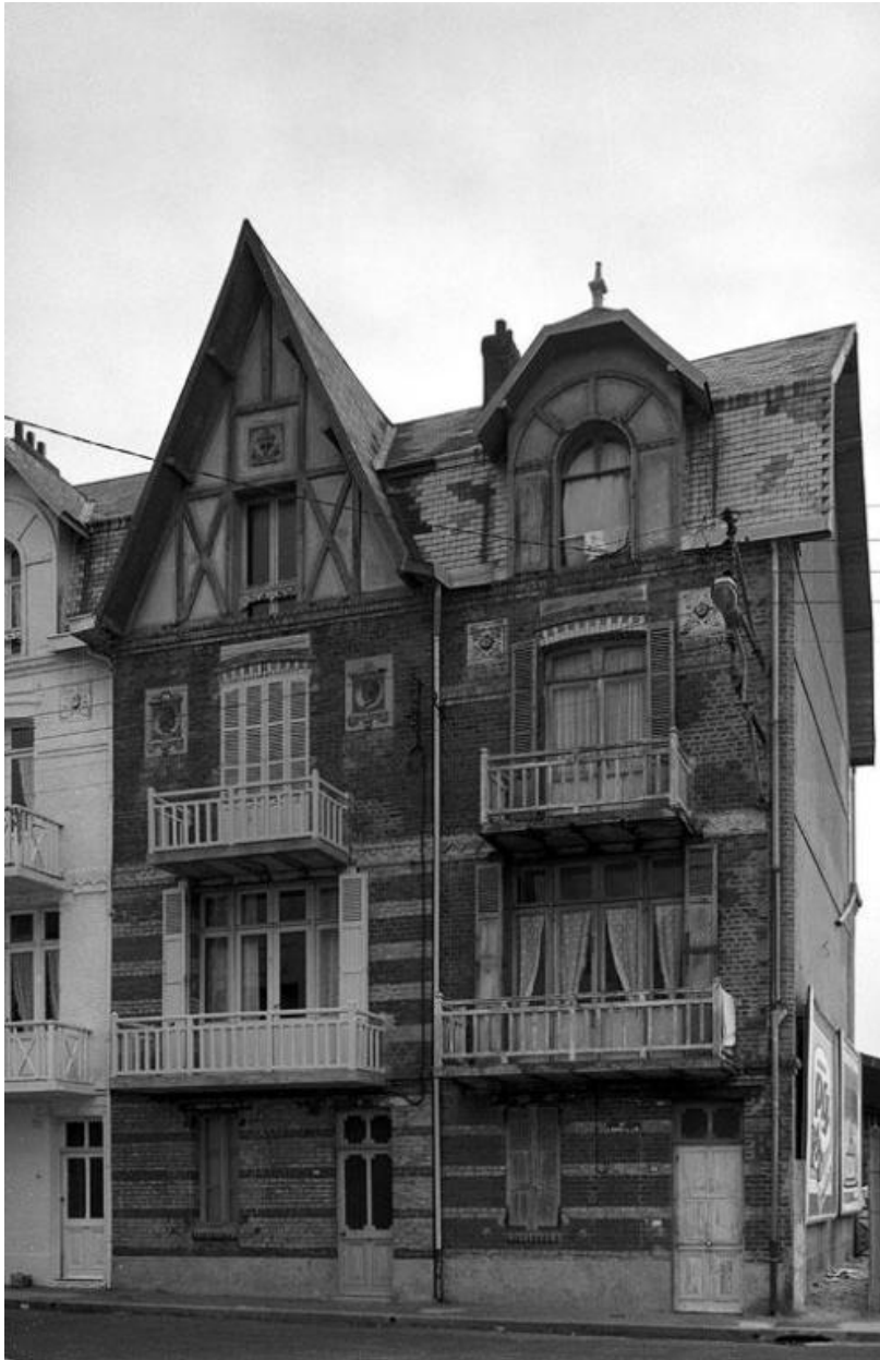
Vue d'ensemble des façades des n° 4 et 6 en 1981.
